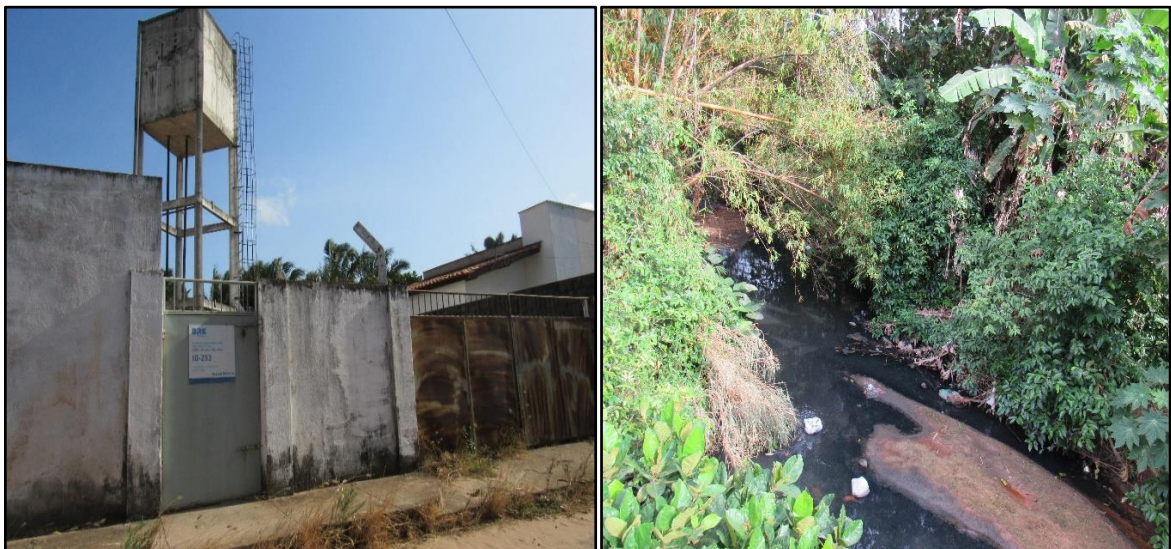
Figura 21 - Contradições na prestação dos serviços da BRK
