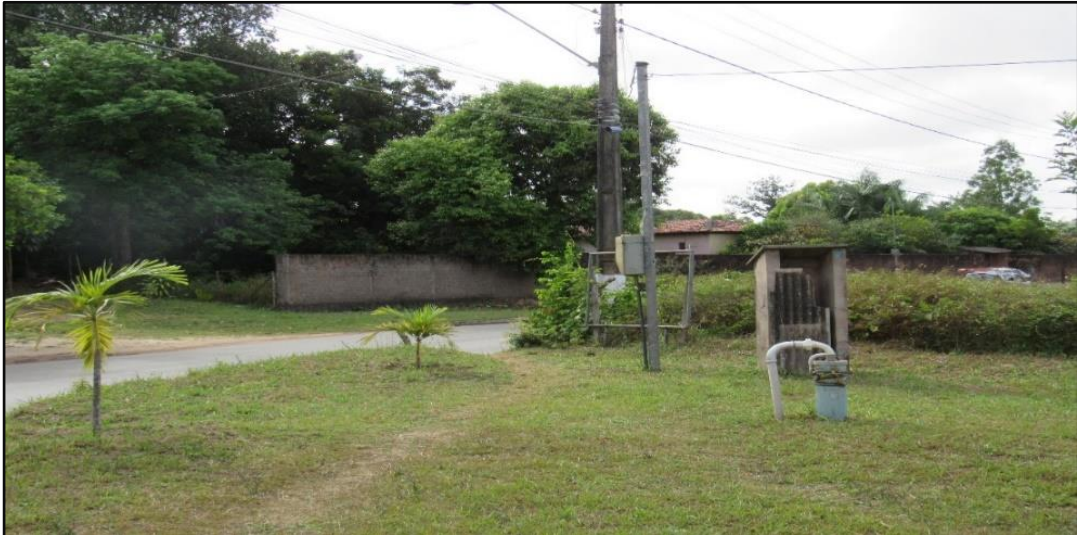
Figura 20 - Poço comunitário no Sítio Grande
