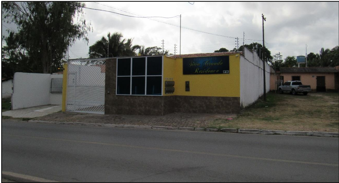
Figura 14 - Condomínio Residencial Sítio Grande
