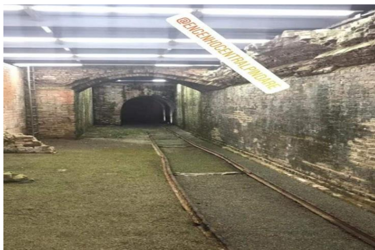
Imagem 2: Trilhos escavados da antiga estrada de ferro do Engenho Central São Pedro. Fonte: Lindalva dos Santos (2020)
