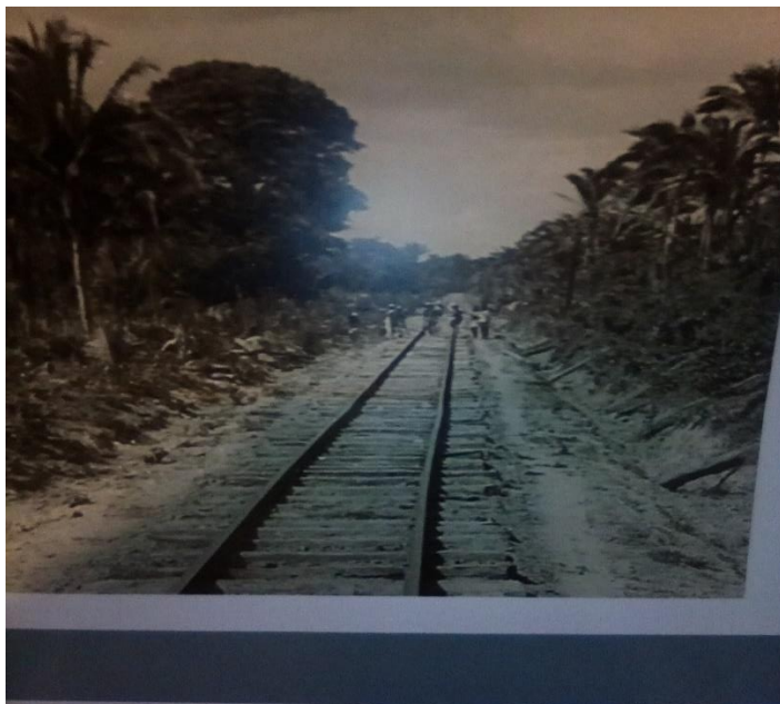
Imagem 6: Um trecho da via férrea, com trabalhadores, passando na mata do babaçu, nos limites do município de Coroatá.
