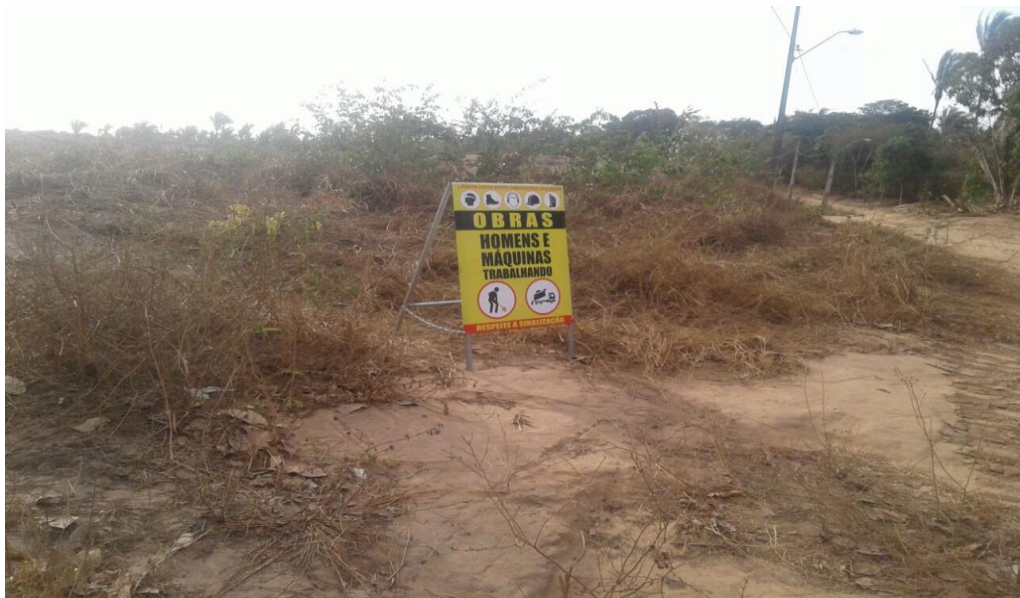
Figura 1 - Avanço do desmatamento na área do Cajueiro, São Luís -MA
