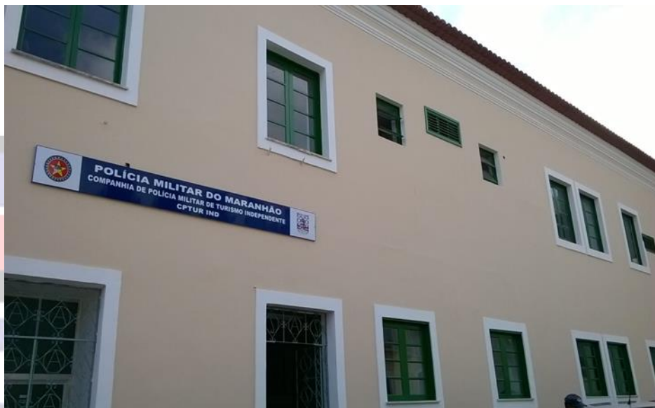
FOTO 1: ATUAL PRÉDIO DA CPTUR IND
