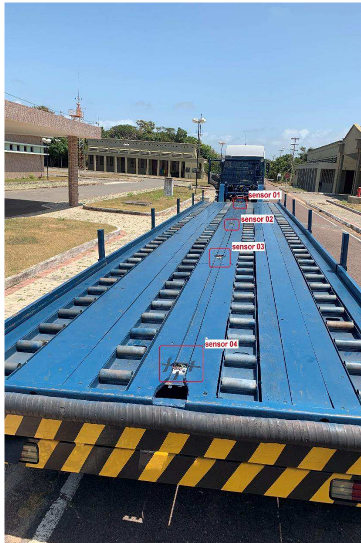
Figura 27: Instalação dos sensores.
