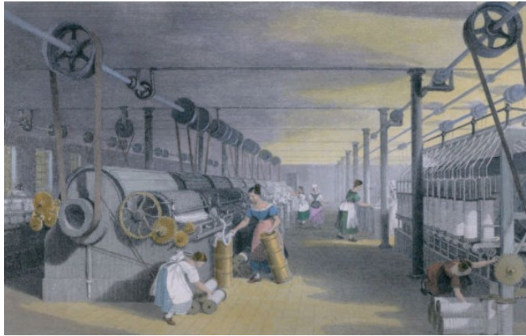
Figura 17 - Processos automatizados e correias transportadoras na indústria (SOUSA, 2019)
