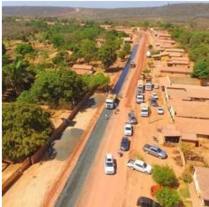
Figura 4 - Tratamento Superficial Duplo aplicado na MA-012
