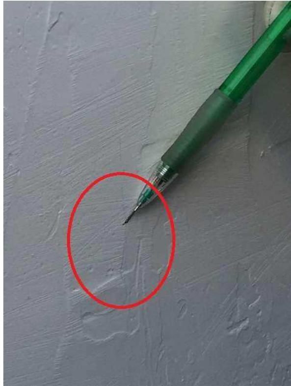
*Imagem 6: fissura na parte (externa/superior)*
