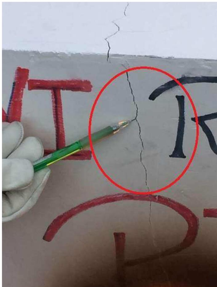
*Imagem 7: fissura se expandindo (frente)*
