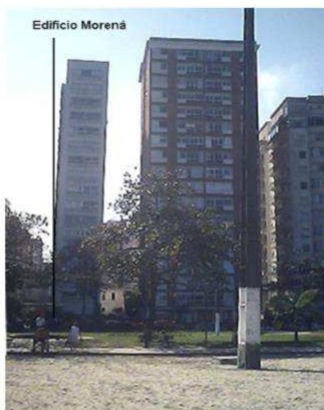
Figura 30: Situação atual do edifício Morená
