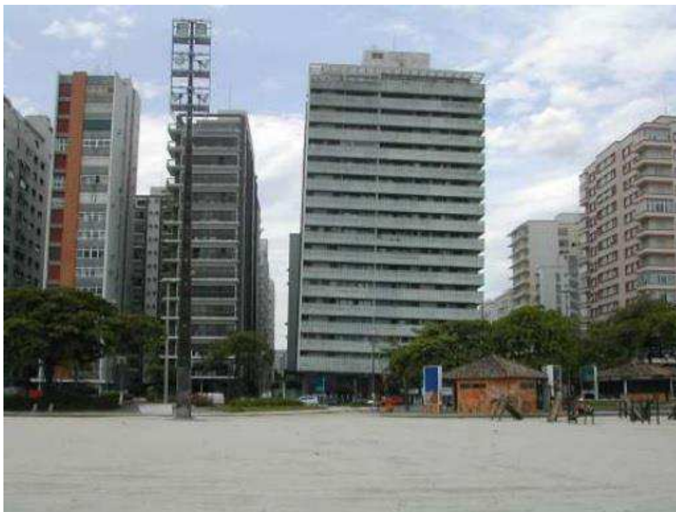
Figura 28: Recalque das edificações em Santos
