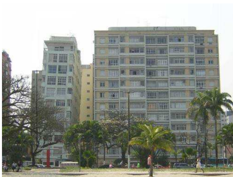
Figura 29: Edifício Maambi a esquerda da foto, inclinado em direção ao edifício Paineiras, à direita
