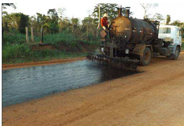
Figura 6 – Execução de Imprimação
