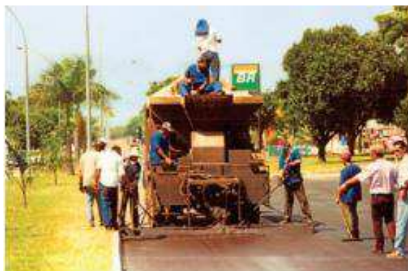
Figura 5 - Execução de Microrrevestimento
