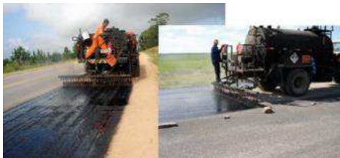
Figura 7 – Execução de Pintura de Ligação.
