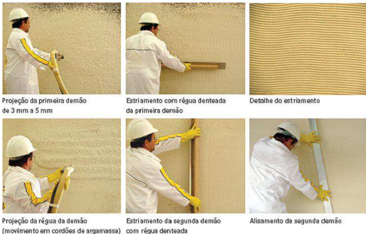
Figura 5 - Aplicação mecânica de revestimento monocamada
