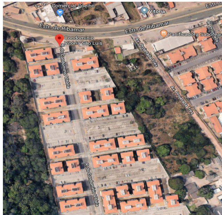
Figura 29 - Condomínio Vitória São Luís
