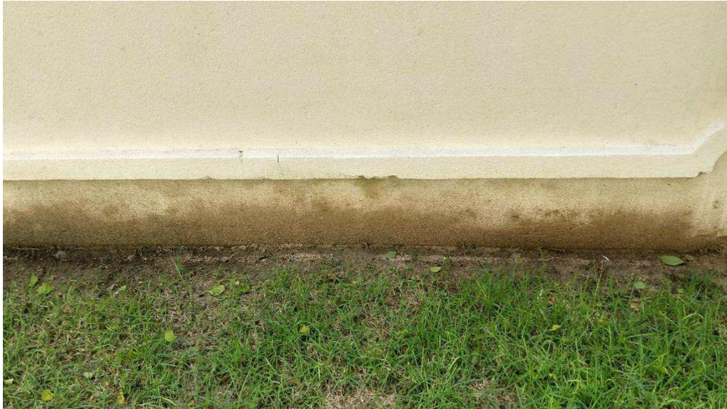
Figura 45 - Mancha decorrente de micro-organismos (Edifício Paris)
