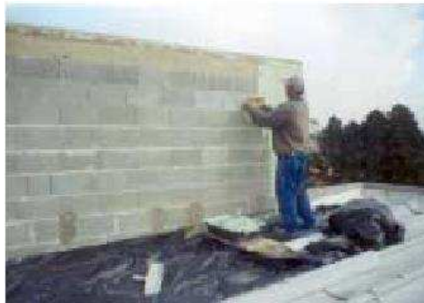
Figura 6 - Aplicação manual de revestimento monocamada
