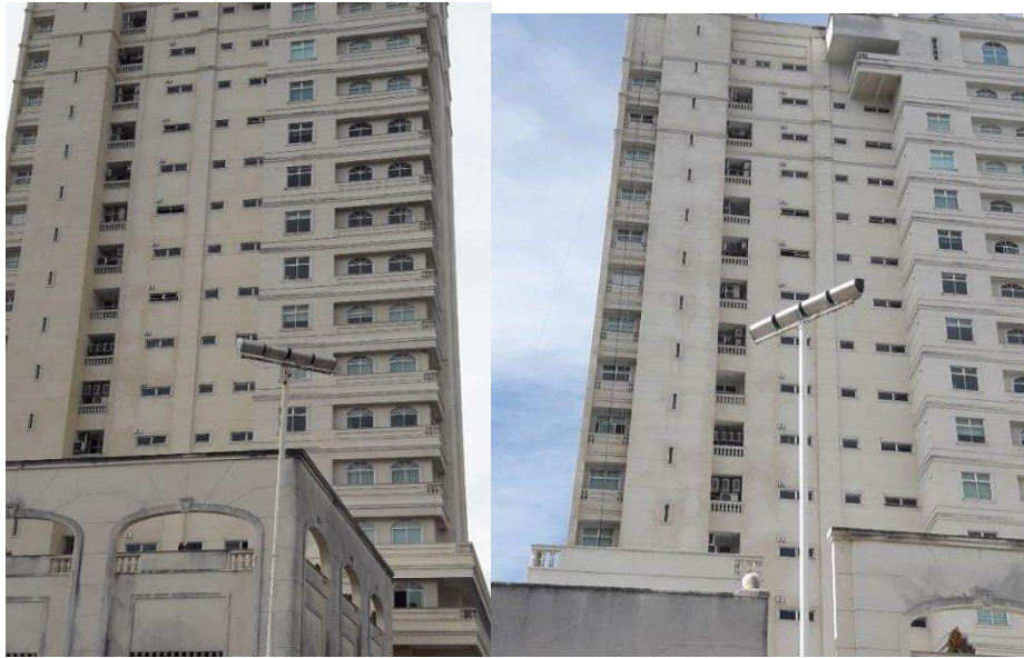
Figura 44 - Revestimento monocamada da torre após limpeza parcial
