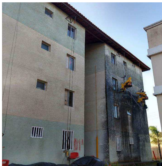
Figura 50 - Lavagem de fachada utilizando apenas água à pressão recomendada
