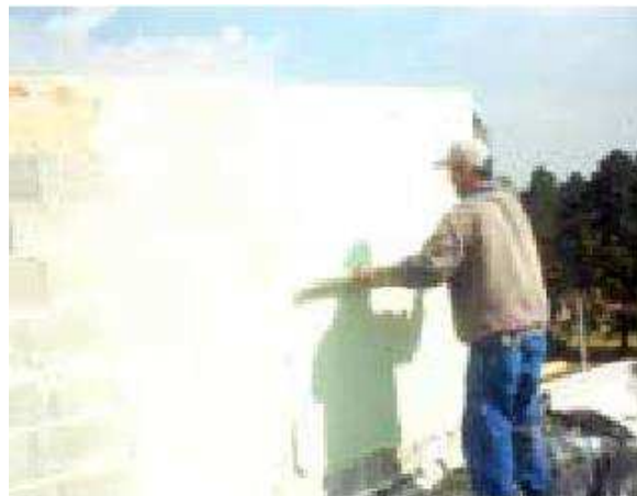
Figura 7 - Aplicação manual de revestimento monocamada
