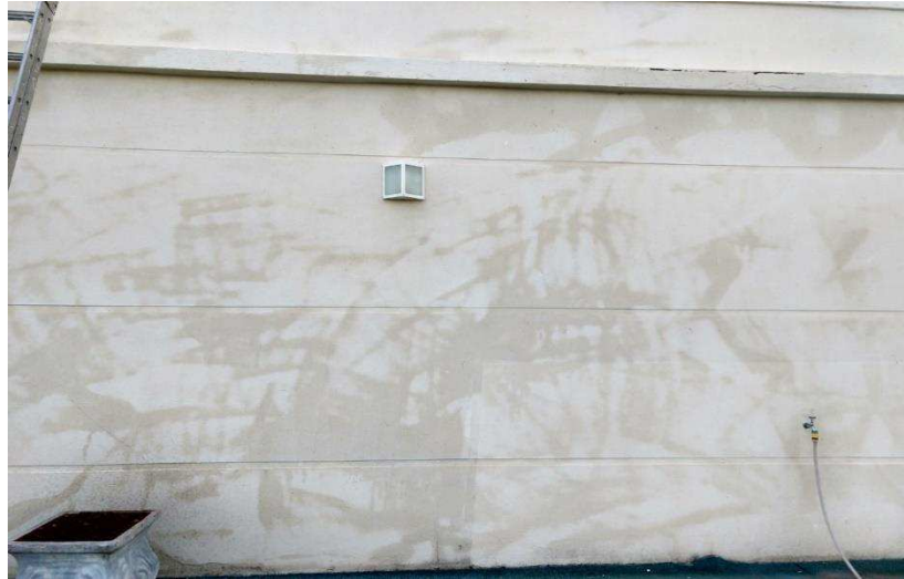
Figura 52 - Muro do Edifício Paris já hidrofugado.
