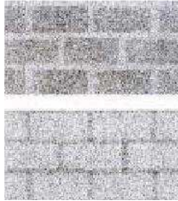
Figura 27 - Espectro ou “fantasma” de juntas
