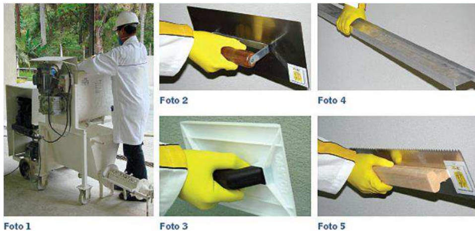
Figura 4 - Ferramentas utilizadas para execução da Monocapa
