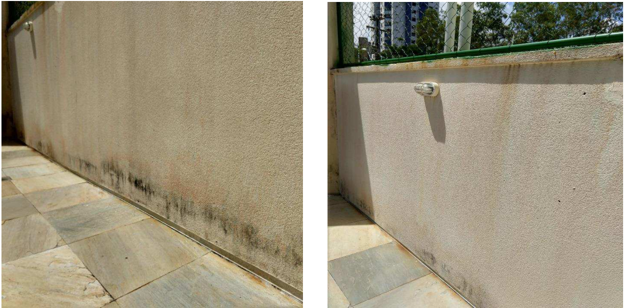
Figura 48 - Manchas decorrentes de escurrimento
