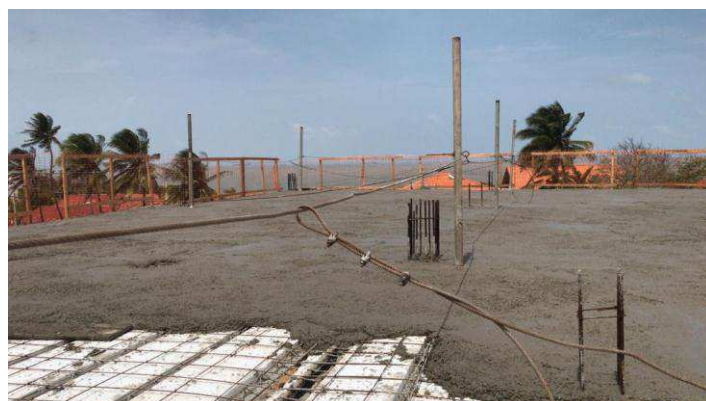
Figura 26 - Concretagem de laje pré-moldada II
