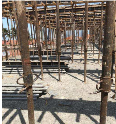
Figura 21 - Estrutura de laje pré-moldada escorada
