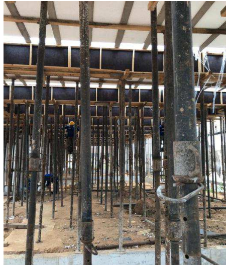
Figura 23 - Estrutura escorada e preenchida com blocos EPS
