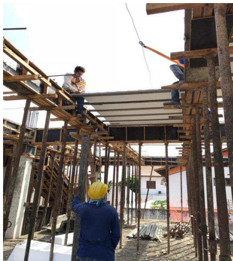
Figura 22 - Colocação dos blocos EPS entre as vigotas
