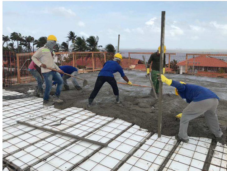
Figura 25 - Concretagem da laje pré-moldada
