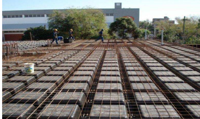
Figura 29 - Aplicação da armação na laje nervurada com cubetas
