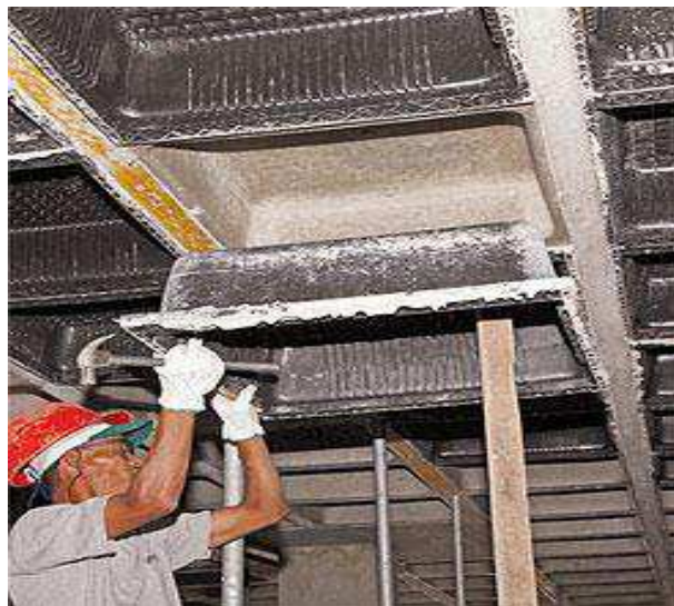
Figura 30 - Retirada de caixotes da laje nervurada
