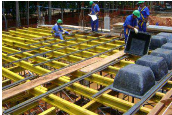
Figura 28 - Instalação das cubetas reaproveitáveis na laje nervurada
