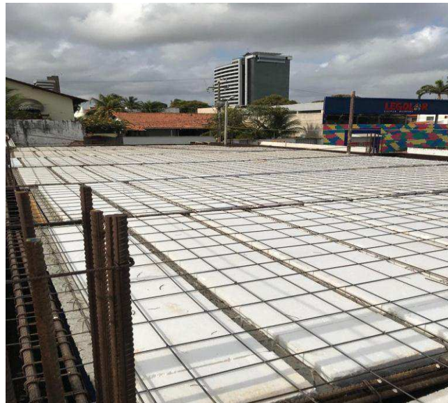
Figura 24 - Malha de aço aplicada para laje pré-moldada
