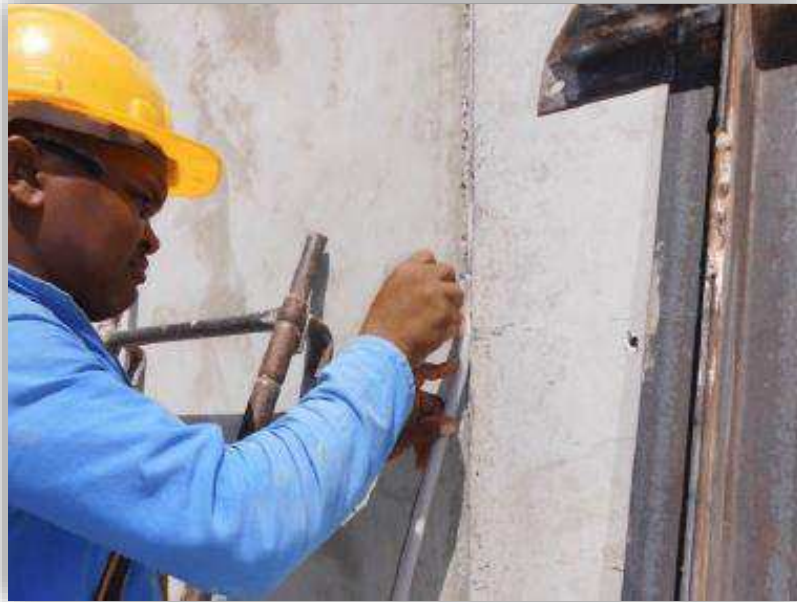
Figura 37 - Colocação do delimitador de profundidade de junta
