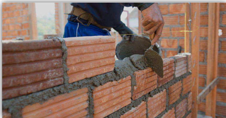
Figura 10 - Execução de alvenaria de vedação
