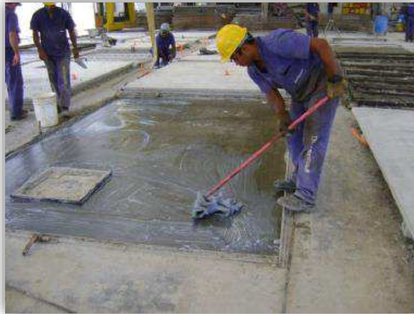
Figura 32 - Aplicação de desmoldante na pista de concretagem de fábrica
