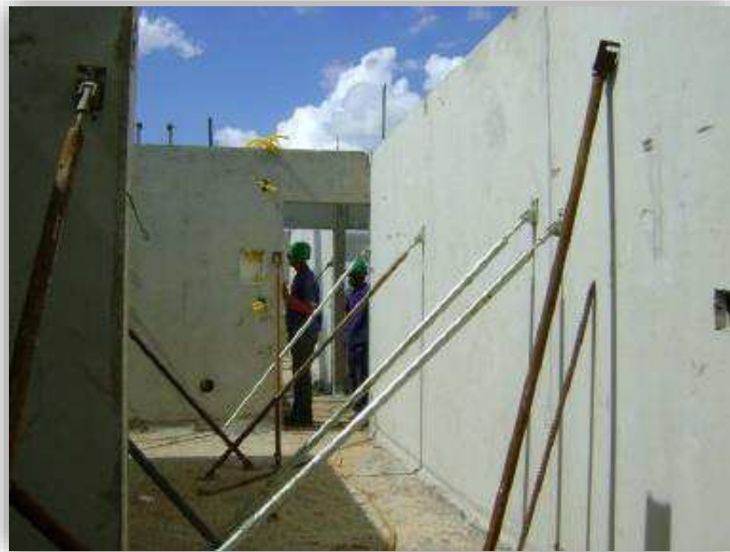
Figura 36 - Escoramento do painel
