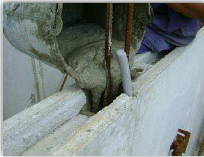
Figura 39 - Grauteamento da ligação entre os painéis, uso de fundo de junta
