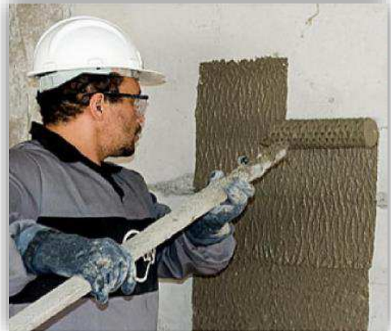
b) Chapiscamento da face da estrutura com rolo para textura;
