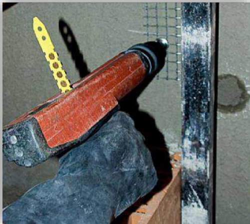
c) Chumbamento de tela metálica com pistola finca-pinos para realização da amarração;
