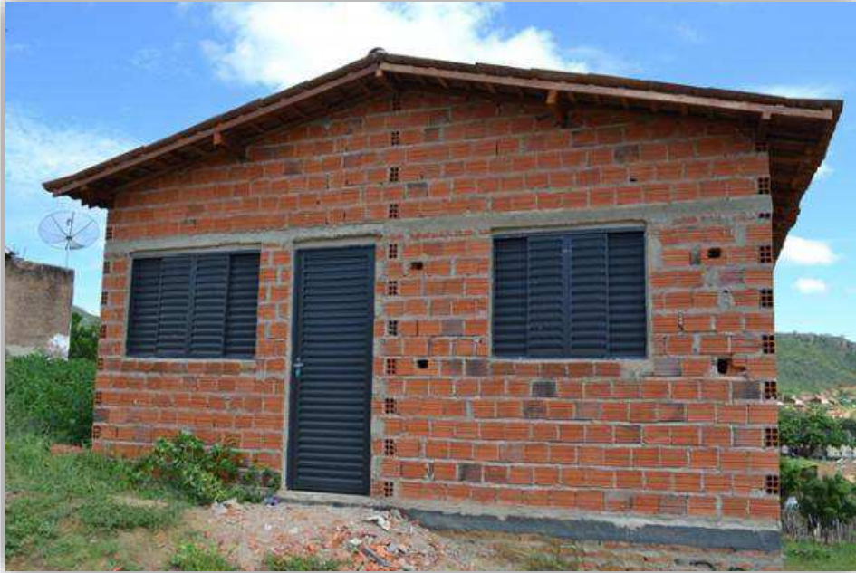
Figura 7 - Obra em alvenaria estrutural
