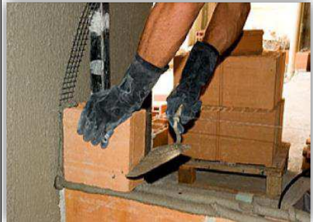
d) Assentamento de bloco cerâmico em contato com estrutura.
