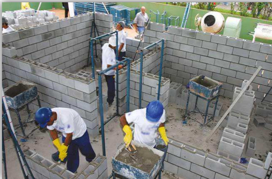
Figura 7 - Obra em alvenaria estrutural
