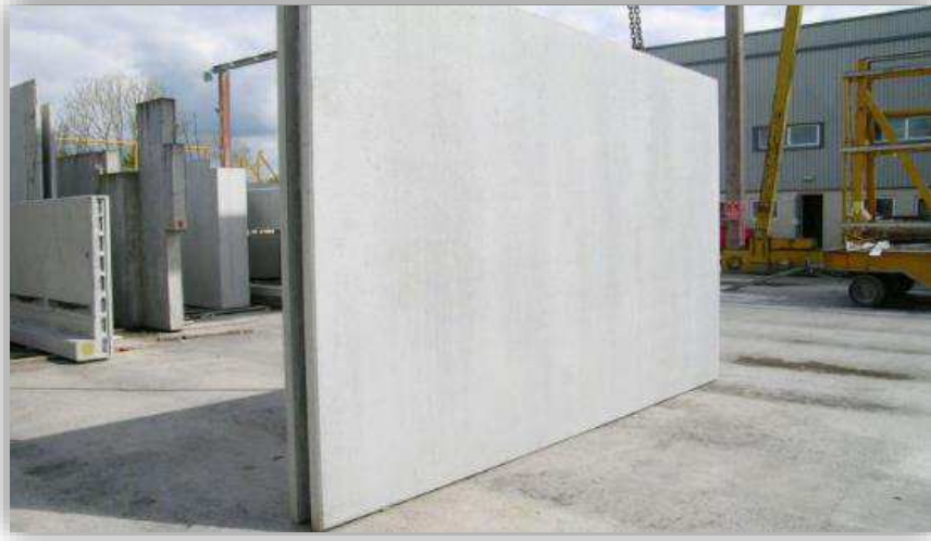
Figura 31 - Módulo de parede dupla pronta para montagem
