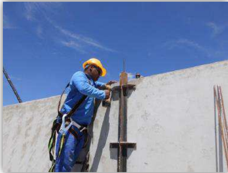
Figura 38 - Fixação do perfil metálico ao painel
