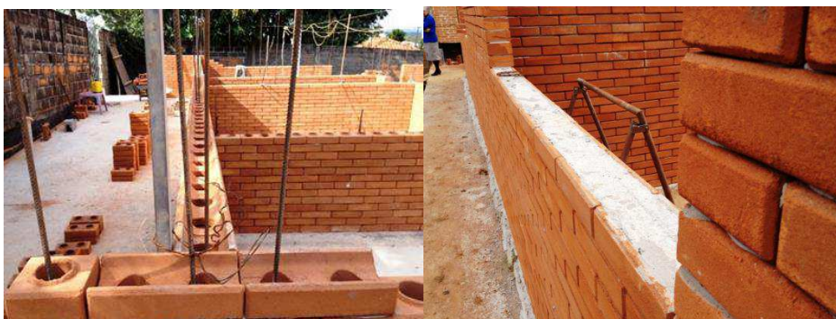
Figura 6 - Ferragens e canaletas – vigas e colunas / contraverga feito nas canaletas
