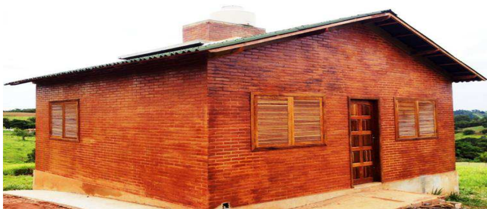
Figura 5 - Casa concluída em Cambuquira/MG
