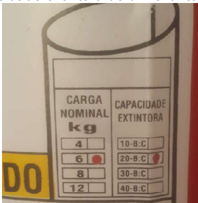
Figura 13 - Capacidade extintora de um extintor fixado na parede
