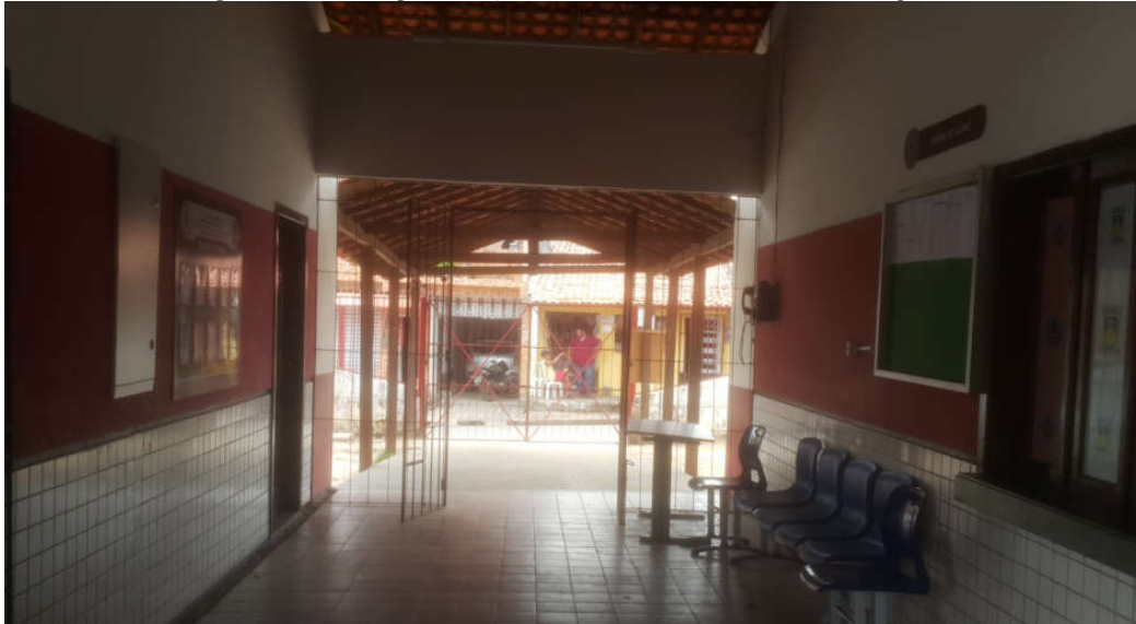
Figura 17 - Segundo portão de acesso as instalações
