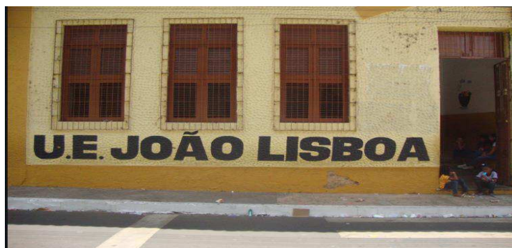
Figura 5: Imagem da fachada da escola Joao Lisboa, cidade de Caxias – MA
