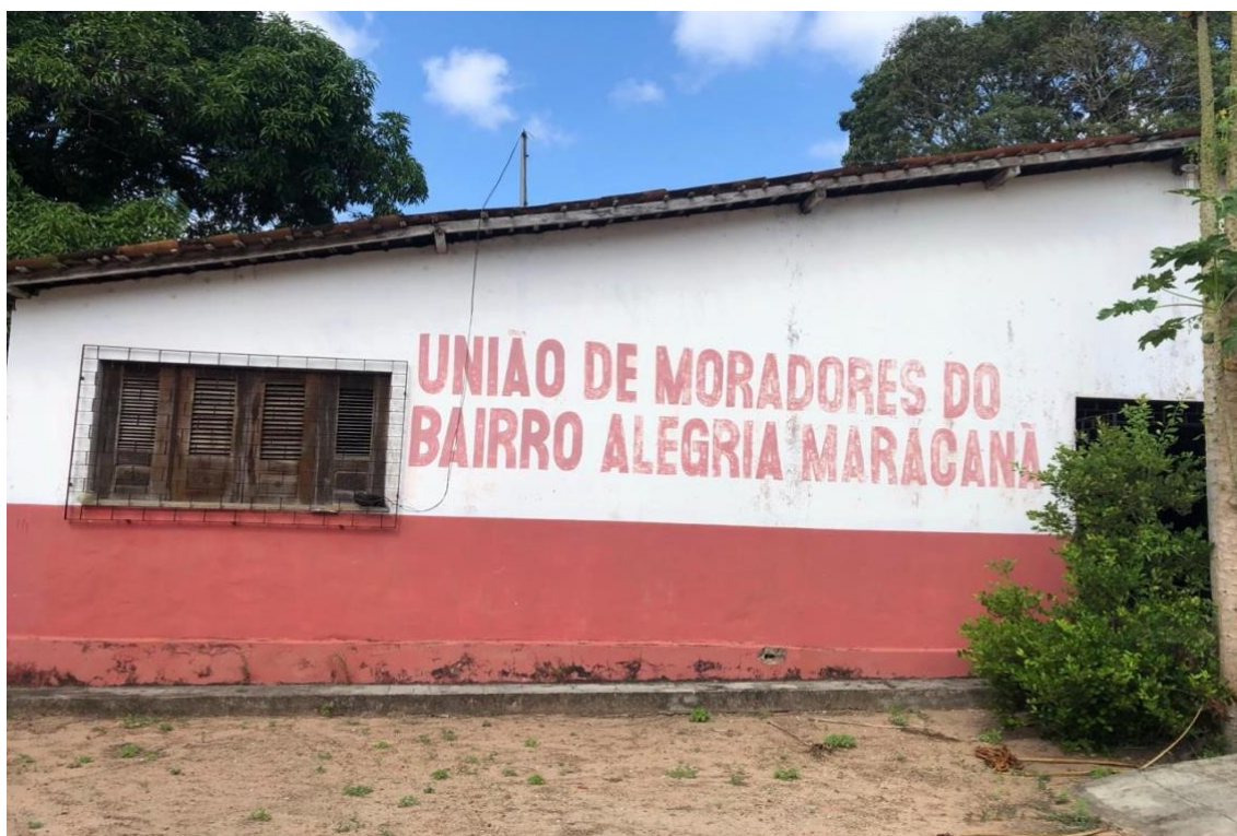
Figura 12- Sede da União dos Moradores do Bairro Alegria Maracanã
