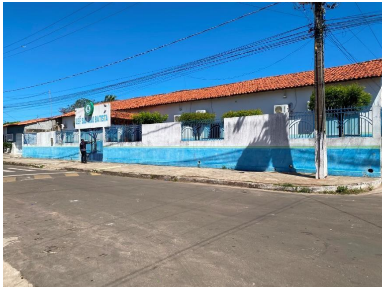
Figura1 – Fachada da Unidade de Ensino Fundamental São João Batista
