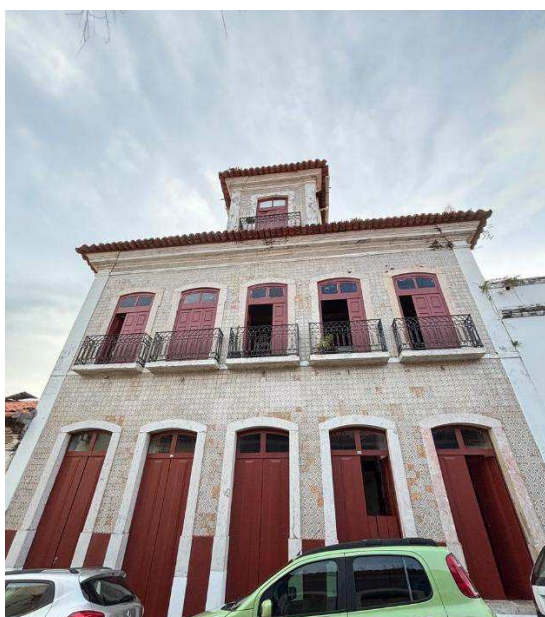
Figura 32 – Fachada do Solar Afonso Pena.
