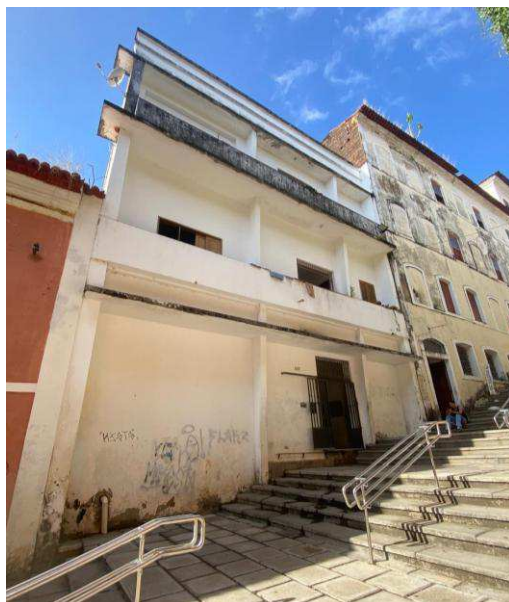
Figura 24 – Fachada do imóvel N° 107, localizado na escadaria da Rua Humberto de Campos, cujas características da fachada diferem muito dos padrões arquitetônicos coloniais encontrados no entorno.
