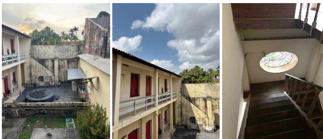
Figura 33 – Vista do pátio interno e da escada do Solar Afonso Pena.
