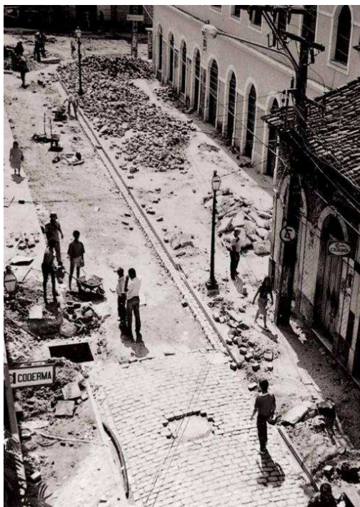
Figura 13 – Recuperação de calçamento na Rua Portugal na década de 1980.
