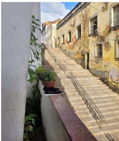
Figura 28 – Escadaria da Rua Humberto de Campos, fotografia feita da sacada do prédio.
