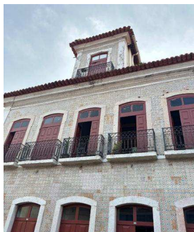
Figura 14 – Detalhe do mirante do Solar Afonso Pena, nº 378.
