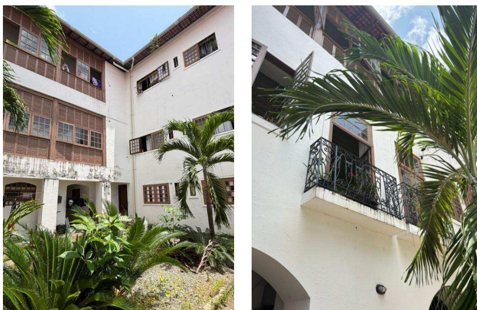
Figura 22 – Pátio interno do edifício, com destaque para as esquadrias em madeira e sacadas para o espaço interno, além do jardim.
