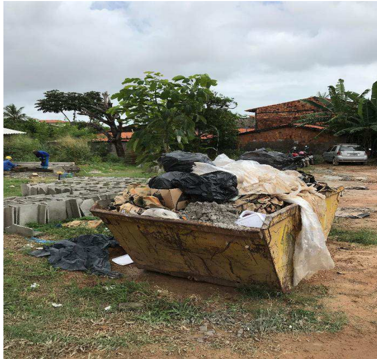
Figura 20 - Estocagem de entulhos em caçamba.
