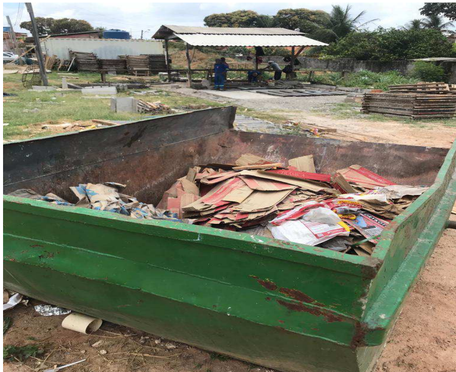
Figura 19 - Estocagem de entulhos em caçamba.
