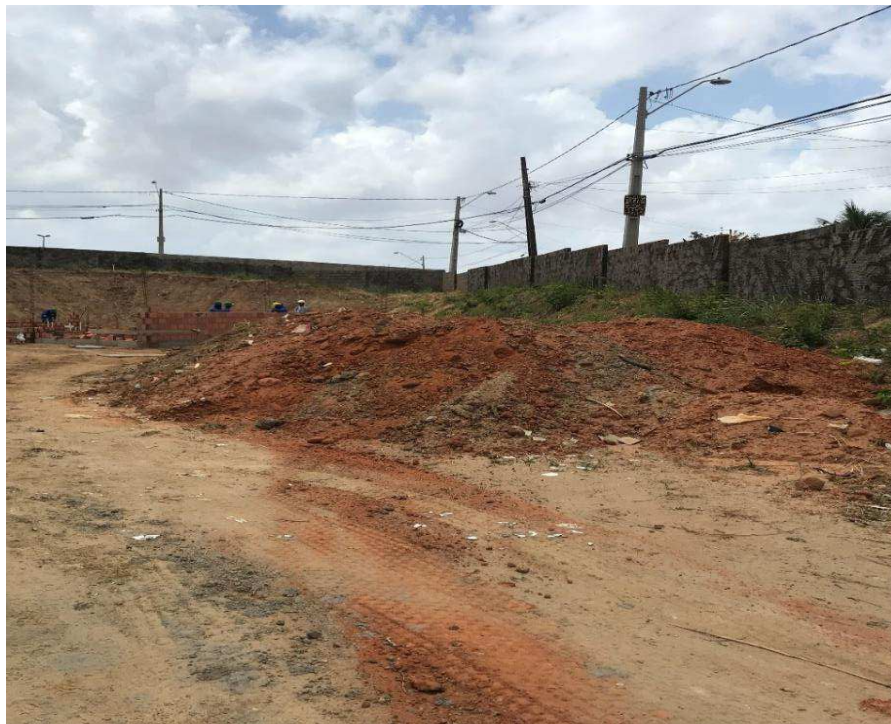
Figura 23 - Amontado de material granular escavado.
