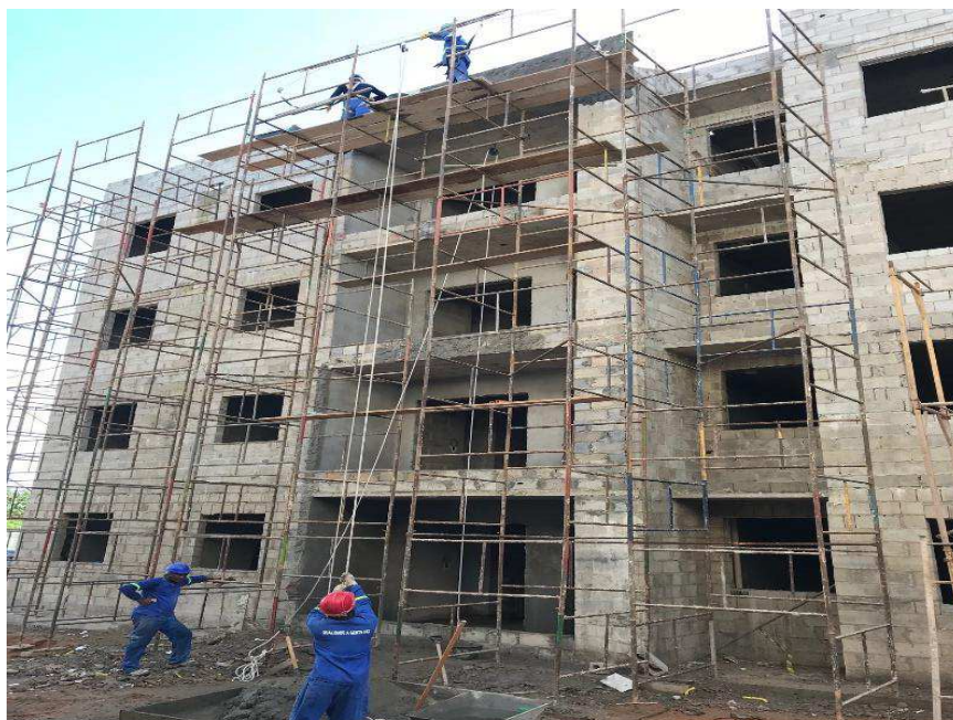
Figura 13 - Execução de Reboco Externo do bloco 5.
