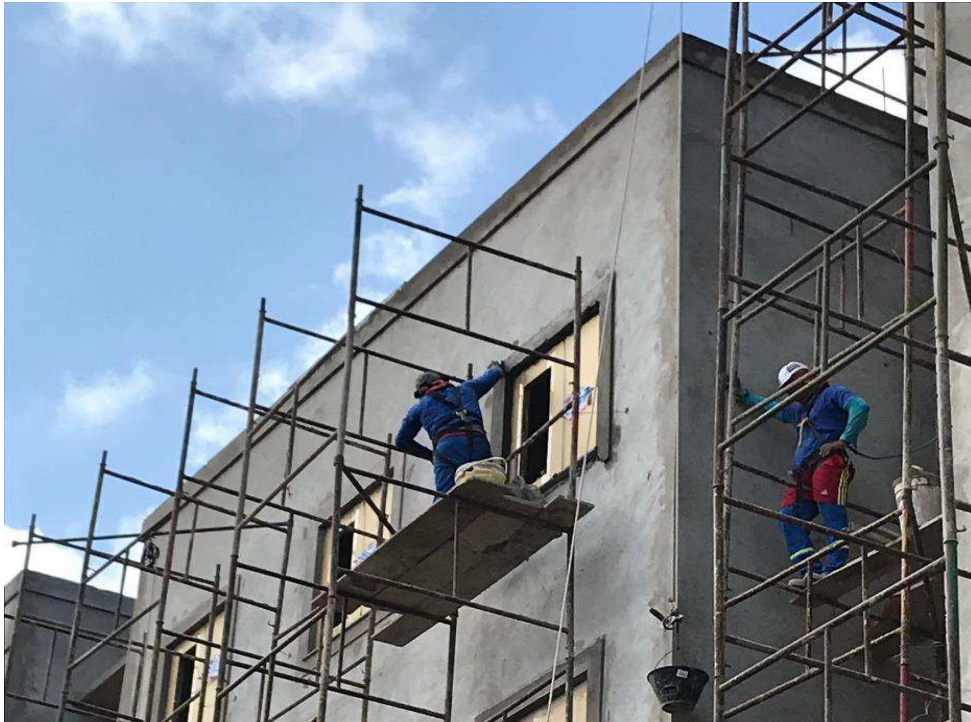
Figura 16 - Confeção de moldura de janela.
