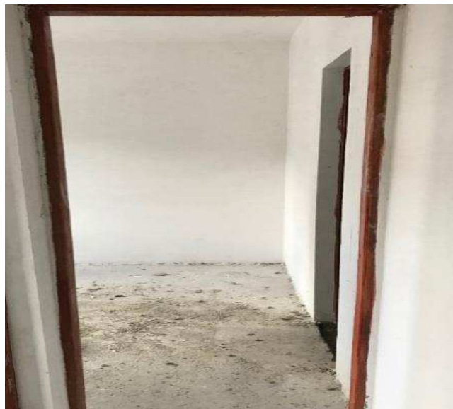
Figura 9 - Caixilho Instalado.
