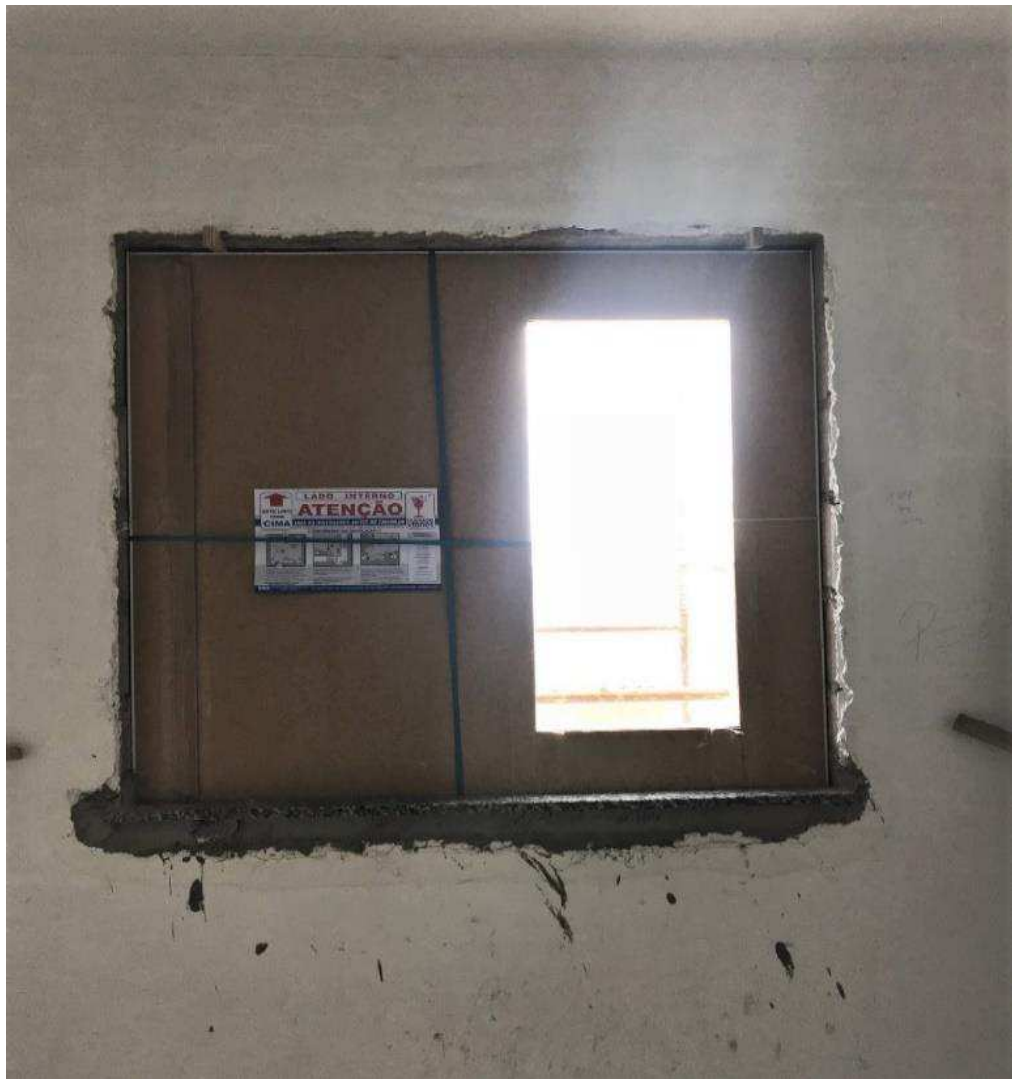
Figura 15 - Peitoril e janela instalados.
