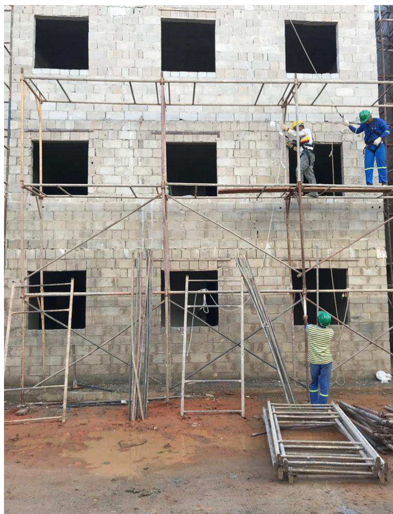
Figura 11 - Montagem de Andaimes.
