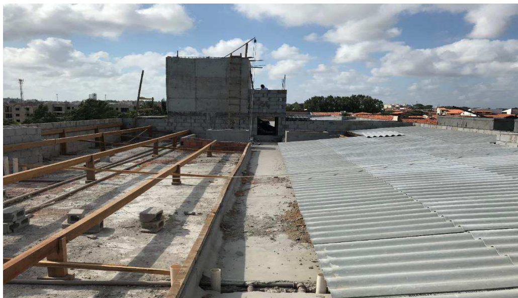
Figura 14 - Cobertura do bloco 1.
