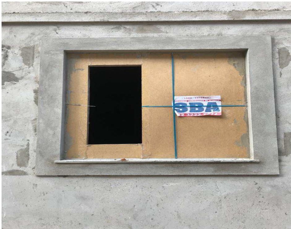
Figura 17 - Moldura de janela finalizada.
