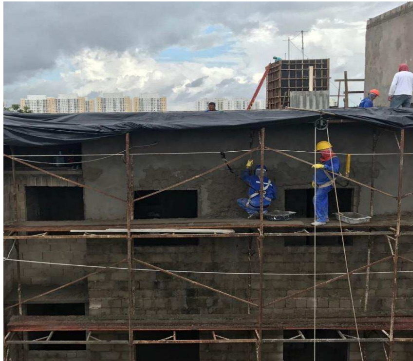
Figura 12 - Execução de Reboco Externo do bloco 5.
