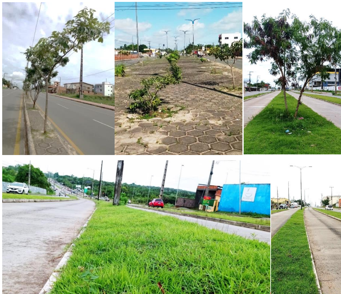
Figura 4 – Vista do Canteiro Central da Avenida dos Holandeses no Município de São José de Ribamar – MA, 2023.
