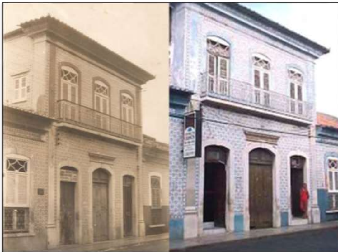
Figura 1- Casa Nobre -Sobrado na rua dos Remédios
