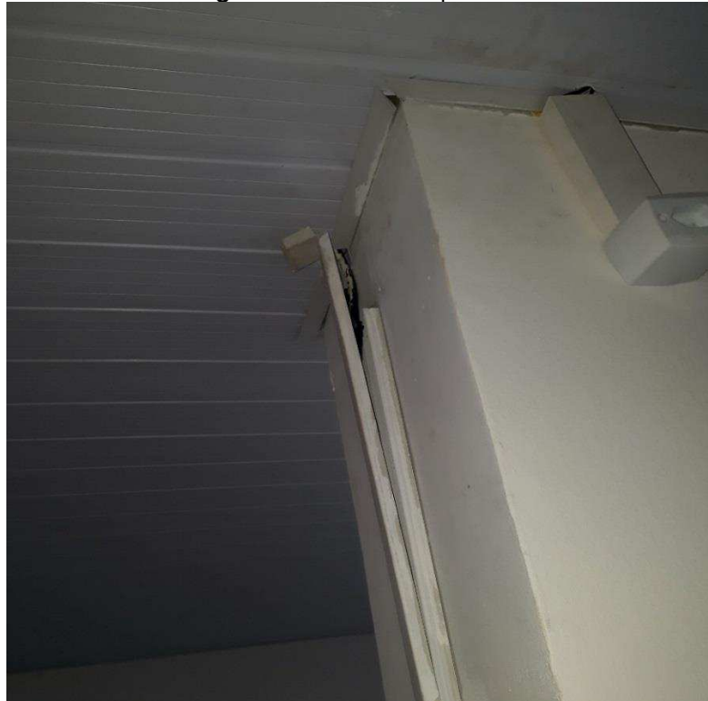
Figura 16 - Pintura de paredes
