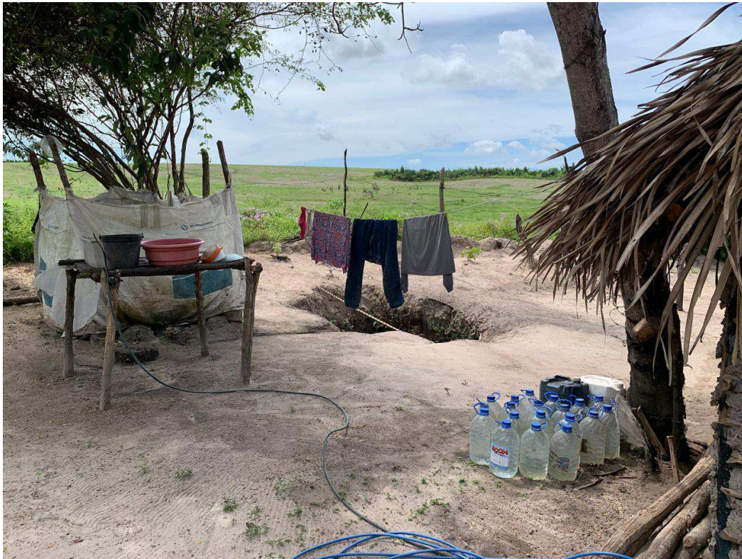
Exemplo de vila que erodiu no quintal de uma casa, a cerca separa o sojeiro da residência Fonte: Autor, 2024.
