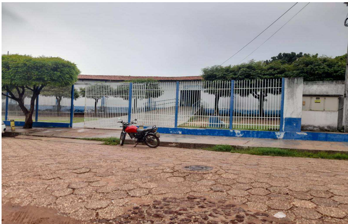
Figura 3 – Fachada da Escola Municipal José Barreto de Araújo
