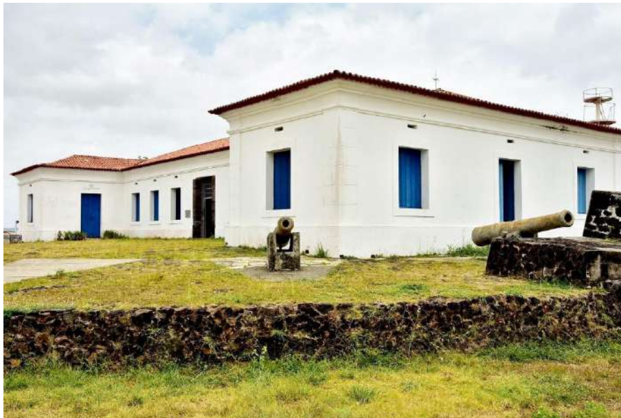
Figura 8 - Forte de Santo Antônio da Barra pós reforma (2020)
