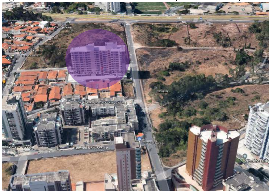
Figura 55 - Condomínio Reserva do Renascença – Rua das Garças
