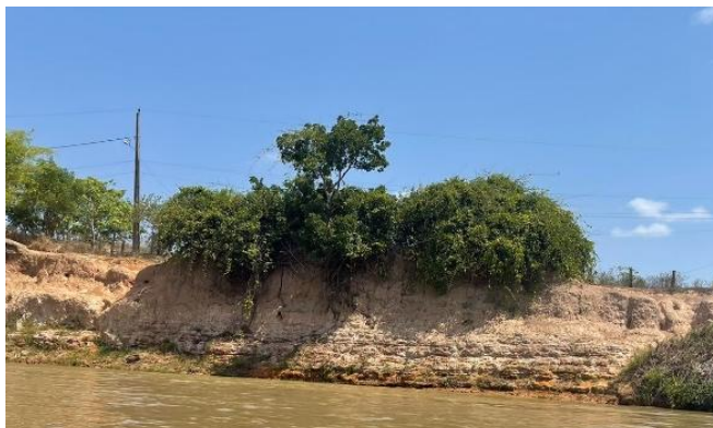
Figura 7: Erosão próxima à margem do Rio Mearim.
