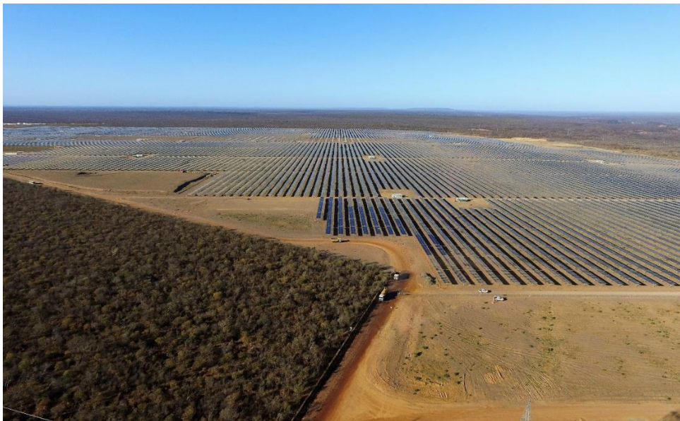
Figura 27 - Fotografia aérea do Parque Solar Nova Olinda
