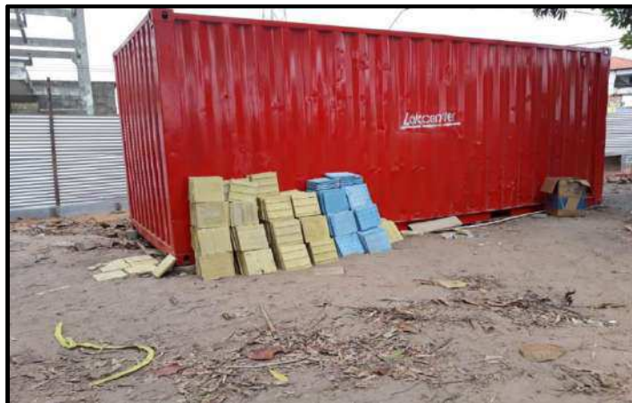
Figura 28 – Containers da Prefeitura de São Luís durante o processo de demolição do piso da Praça das Árvores para a “requalificação”
