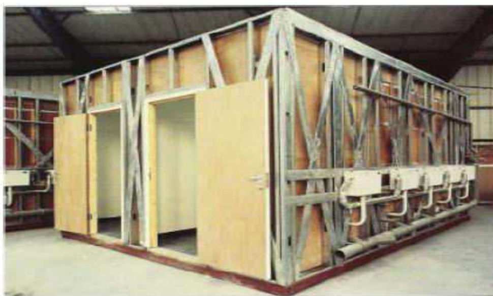
Figura 11- Elemento de construção Modular em Steel frame
