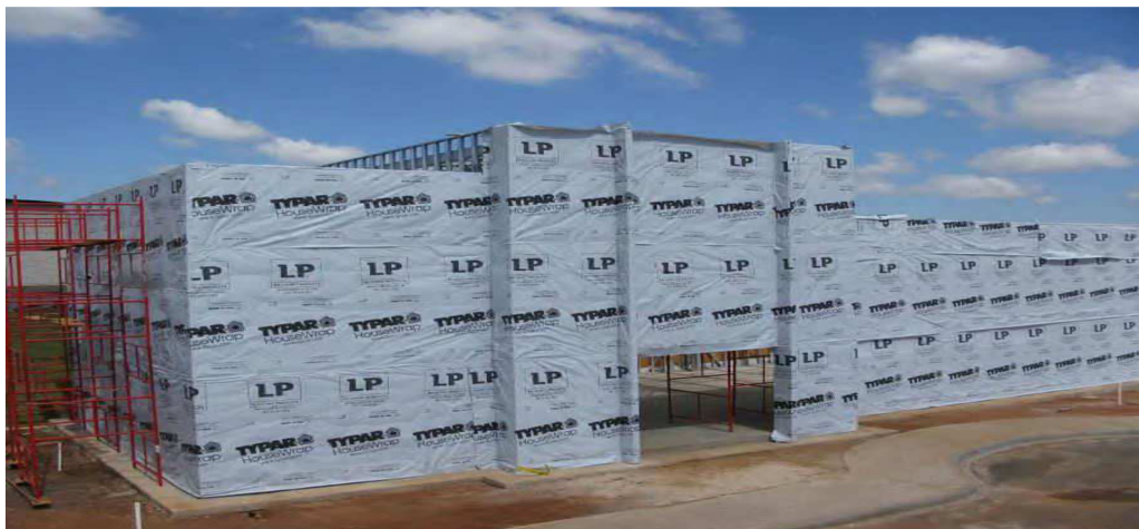
Figura 34- Aplicação de Membrana Hidrófuga
