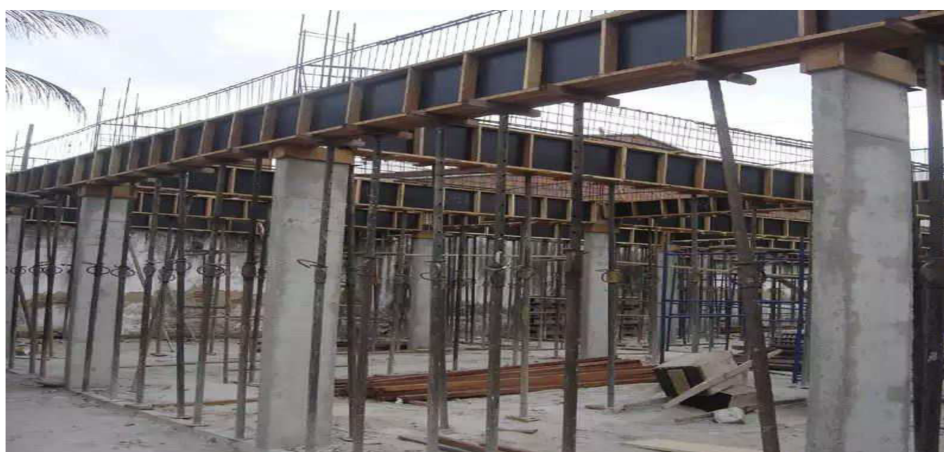
Figura 5-Vigas em Concreto Armado
