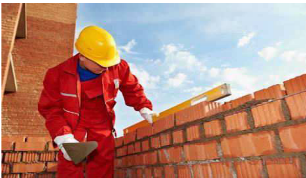
Figura 25- Serviço de Alvenaria
