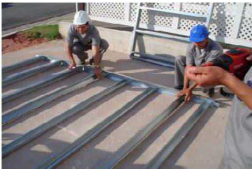
Figura 9- Montagem de painel Steel frame in loco
