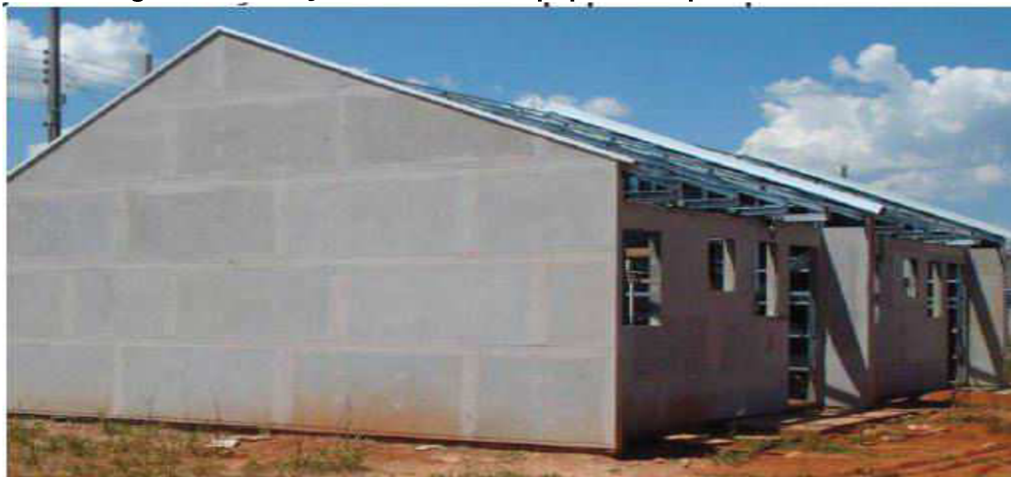
Figura 32- Vedação de residência popular em placas cimentícias
