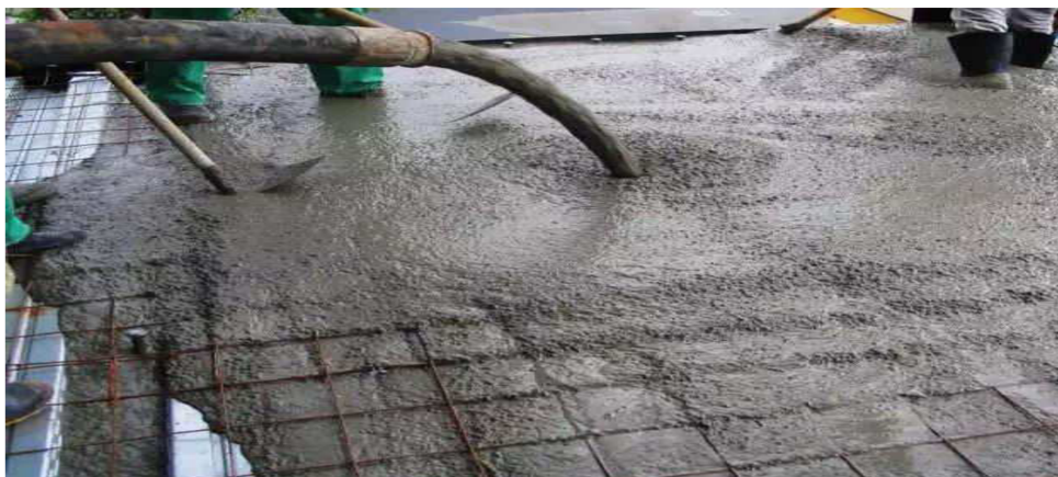
Figura 4- Concretagem de Laje Maciça
