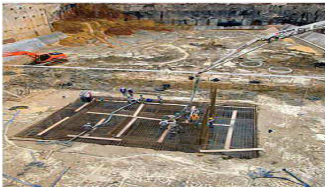
Figura 24- Canteiro de Obras
