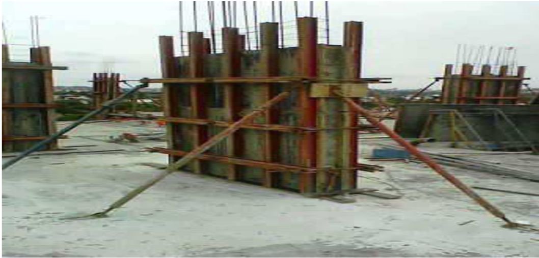
Figura 7- Formas para elementos estruturais
