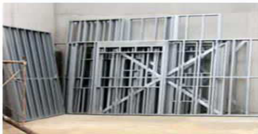
Figura 18- Painéis LSF Prontos
