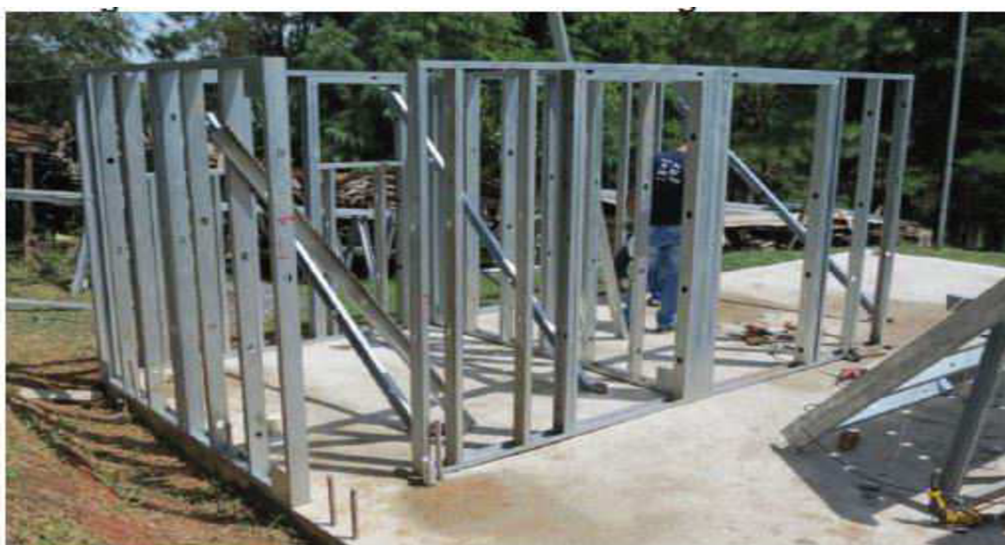
Figura 31- Painéis estruturais em Light Steel Frame
