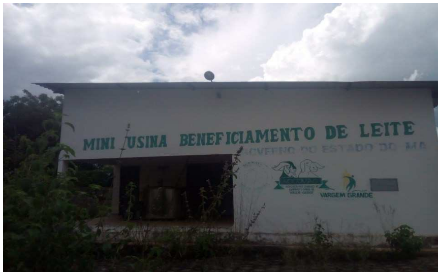
Figura 27 - Usina de beneficiamento de caprinos e ovinos
