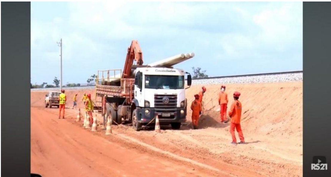
Imagem: duplicação da ferrovia no município de Santa Rita – MA (Fonte: documentário Trilhos da Vida).
