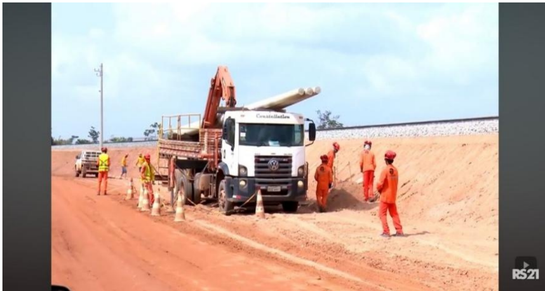
Imagem: duplicação da ferrovia no município de Santa Rita – MA (Fonte: documentário Trilhos da Vida).
