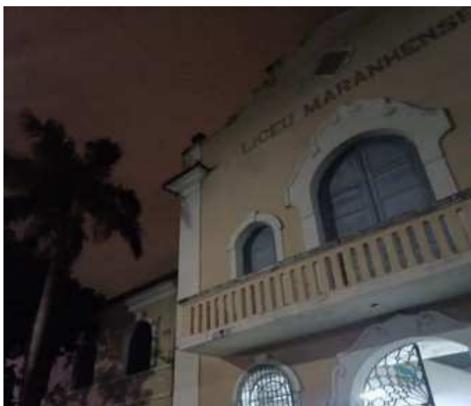
Figura 4 - Fachada frontal do Liceu Maranhense
