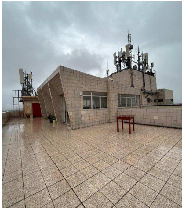
Figura 25 – Terraço na cobertura do Edifício Caiçara.
