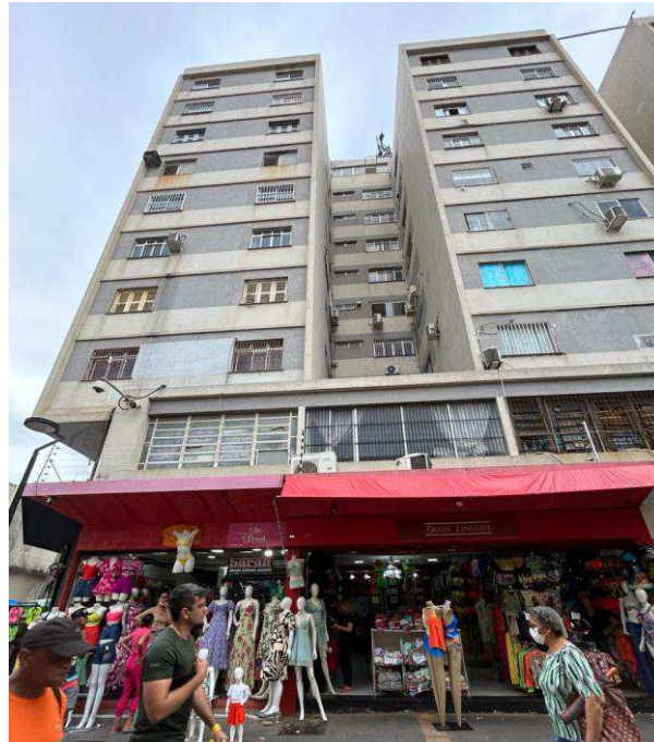
Figura 23 – Fachada Edifício Caiçara.
