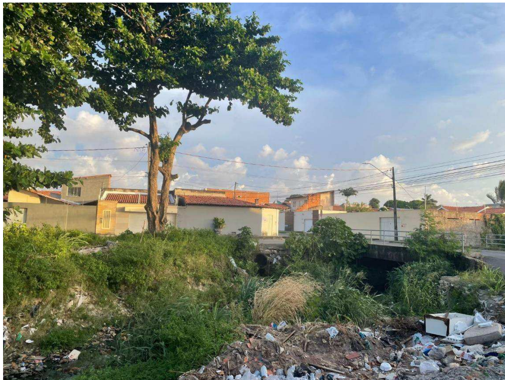
Figura 11 - Presença de esgoto a céu aberto e descarte irregular de resíduos sólidos na lateral do terreno.
