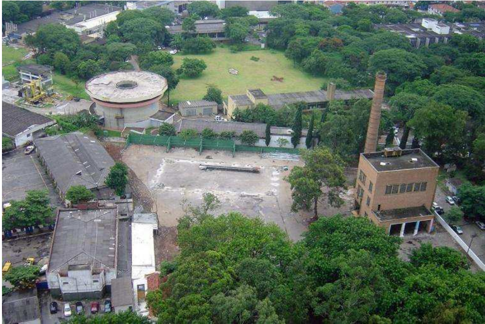
Figura 2 - Terreno antes da requalificação da Praça Victor Civita.
