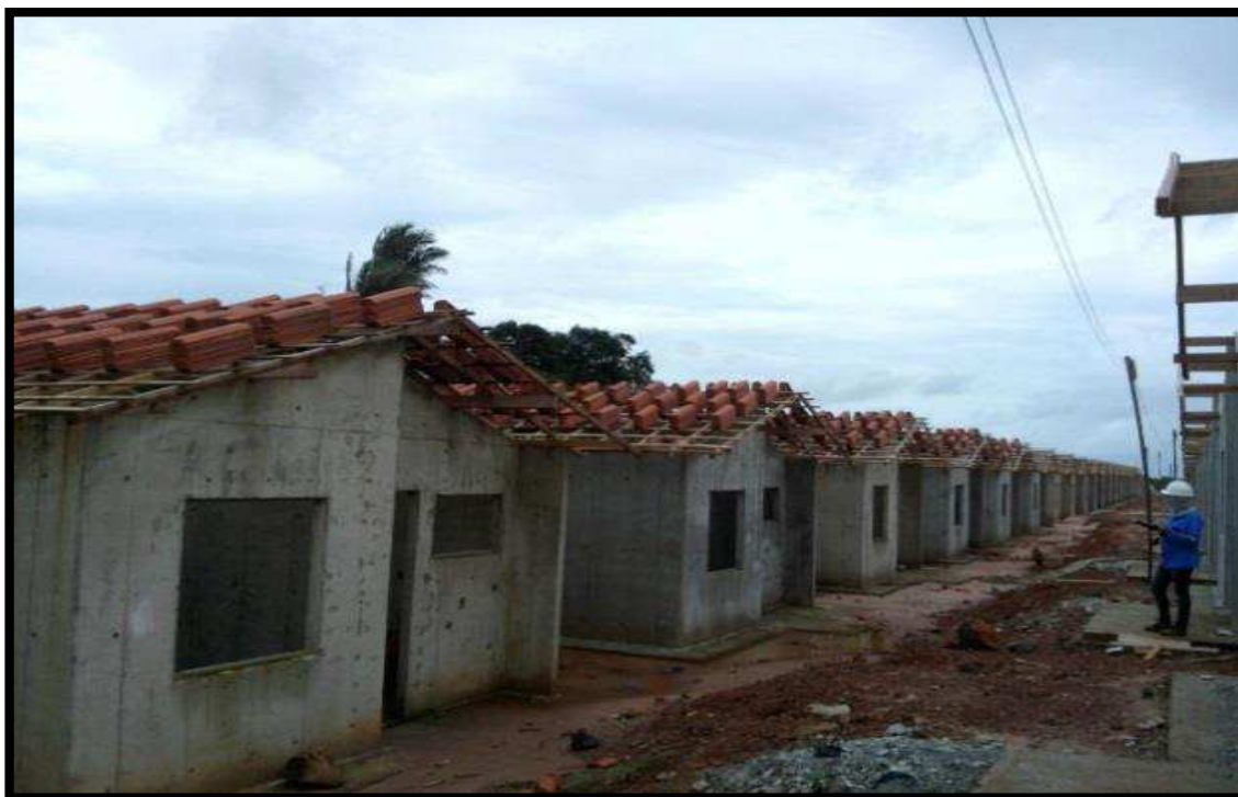
Fig. 8 – Início do telhamento
