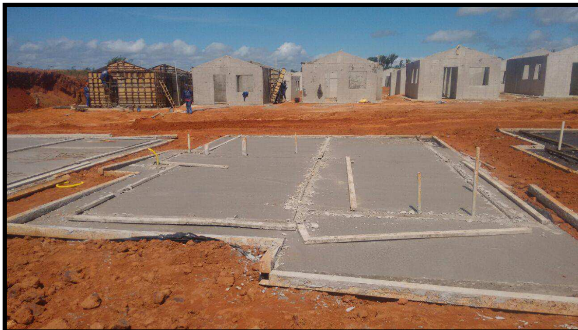
Fig. 2 – Radier concretado
