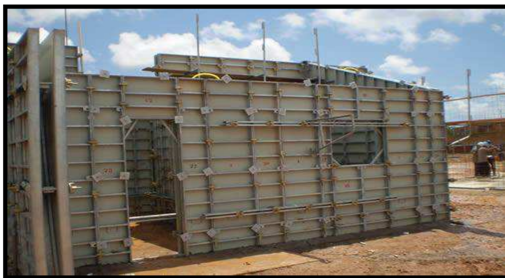
Figura 17 – Fôrma de Alumínio
