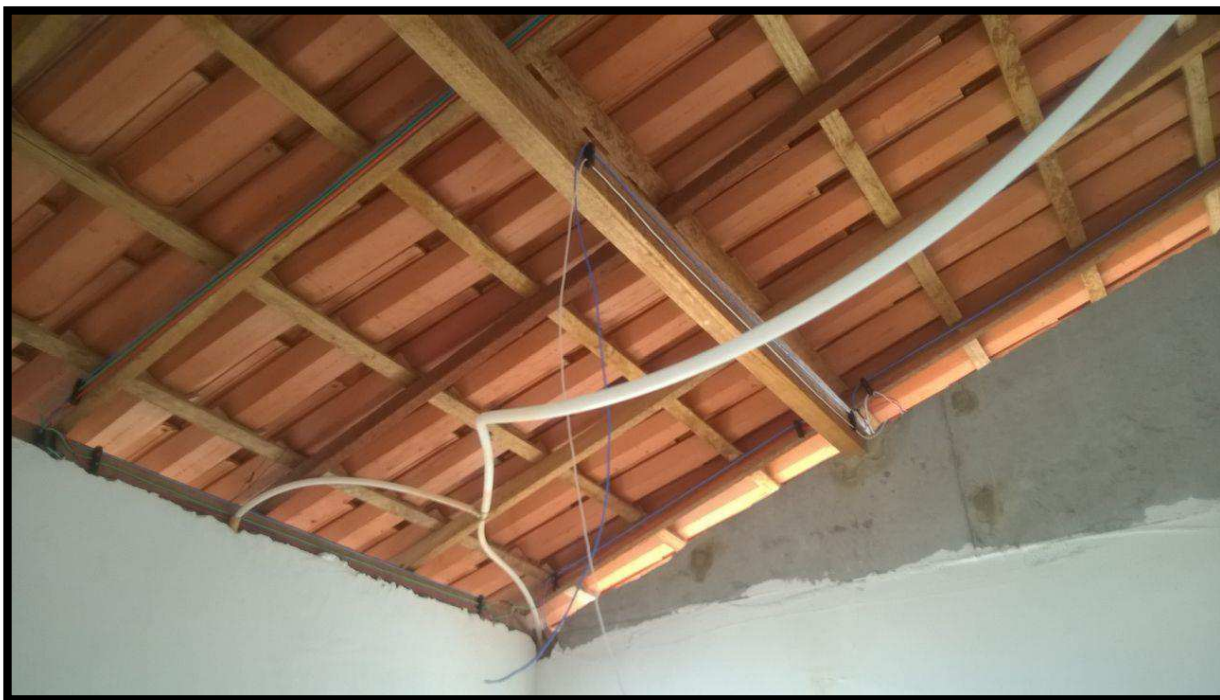
Fig. 20 – Tubulação hidráulica (pex)
