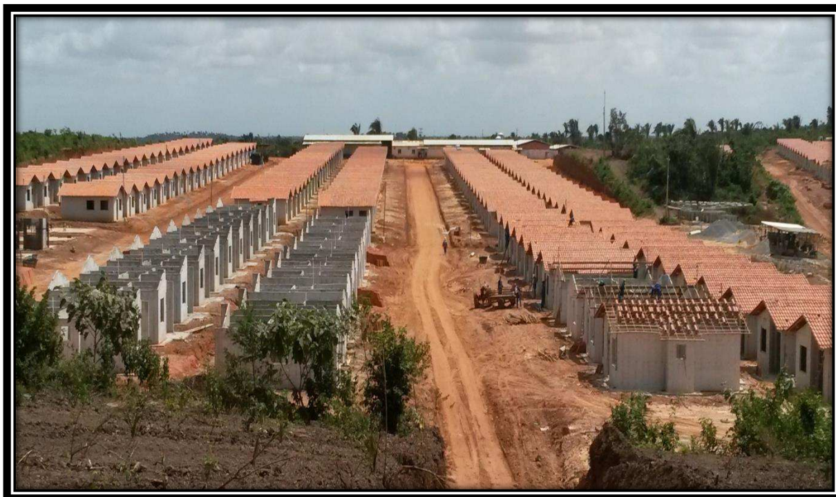
Figura 32 – Foto da execução do residencial Mato Grosso
