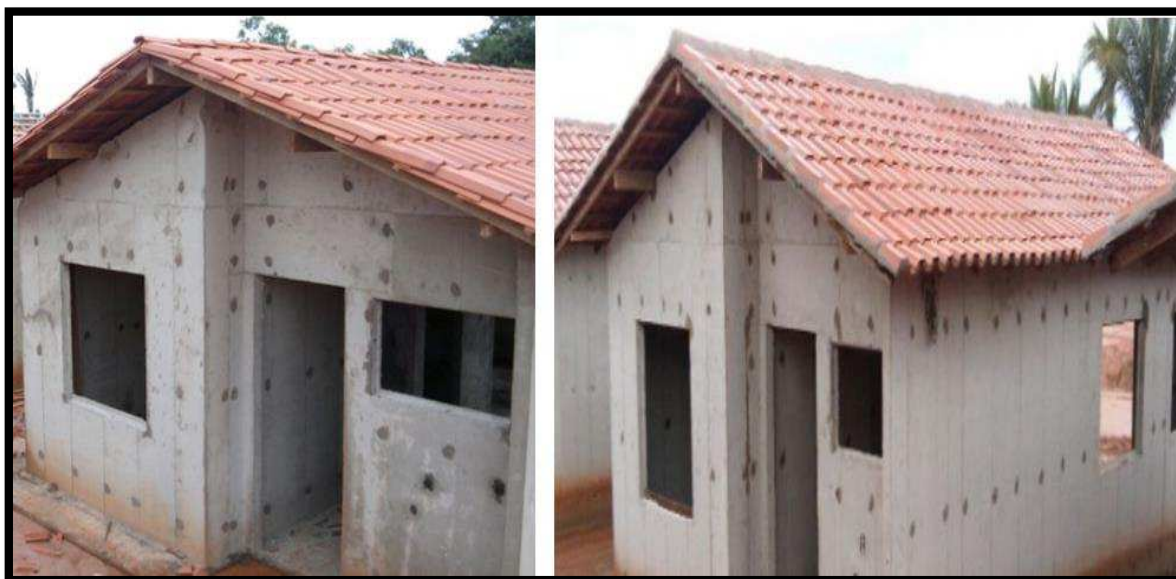
Figura 28 – Acabamento em paredes de concreto
