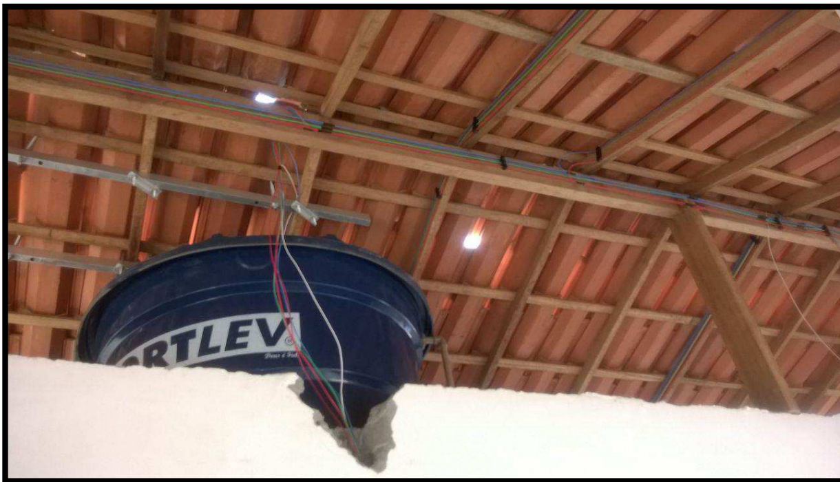
Fig. 19 – Instalação da caixa d'água
