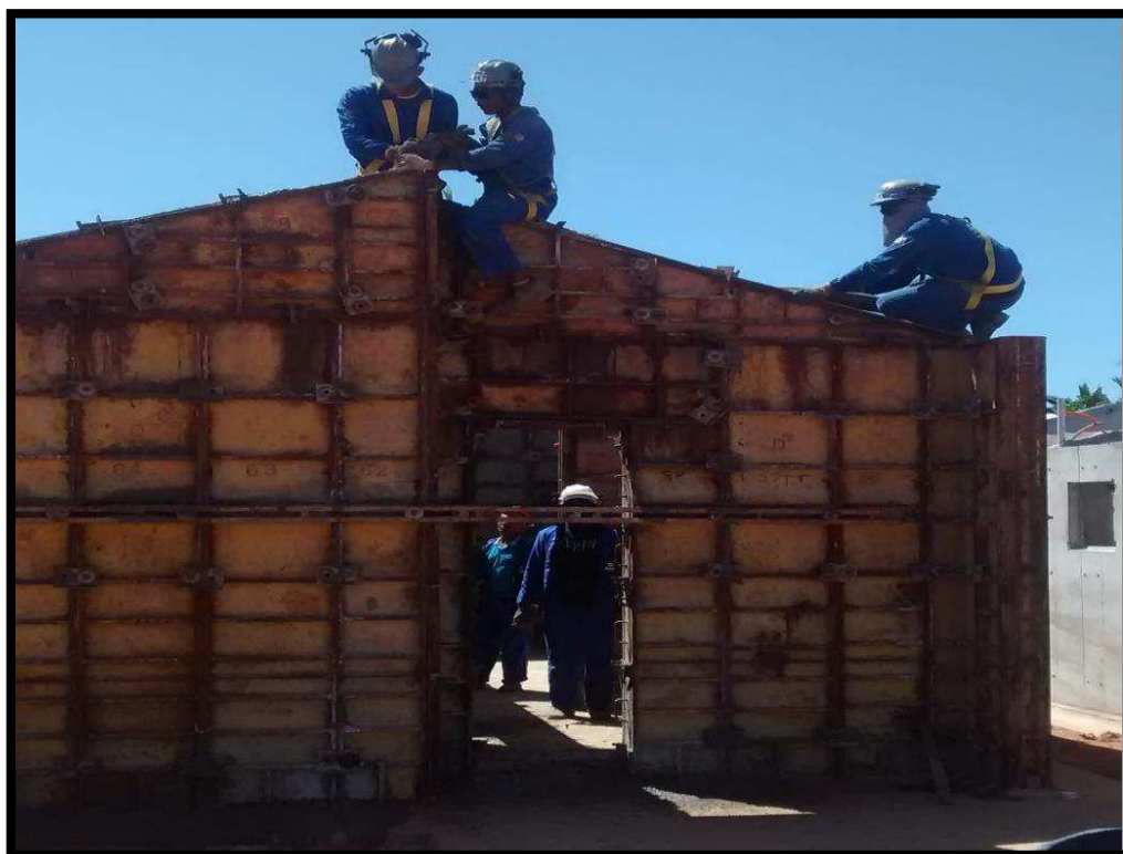
Figura 25 – Concretagem da parede
