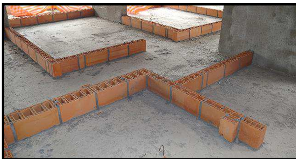
Figura 8 – Marcação da Primeira Fiada
