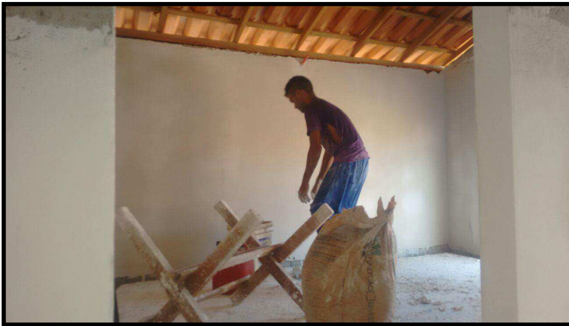
Fig. 12 – Execução do revestimento de gesso
