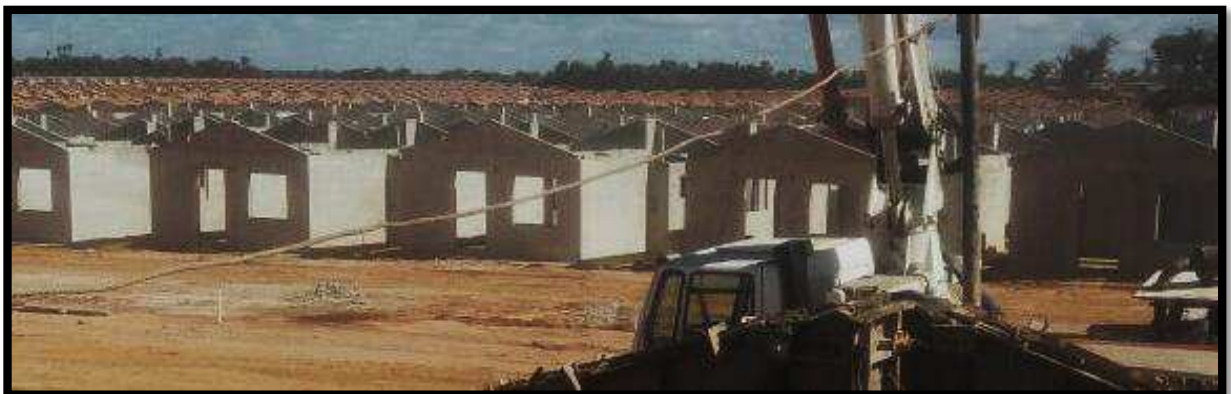
Fig. 7 – Casas em alvenaria de concreto.
