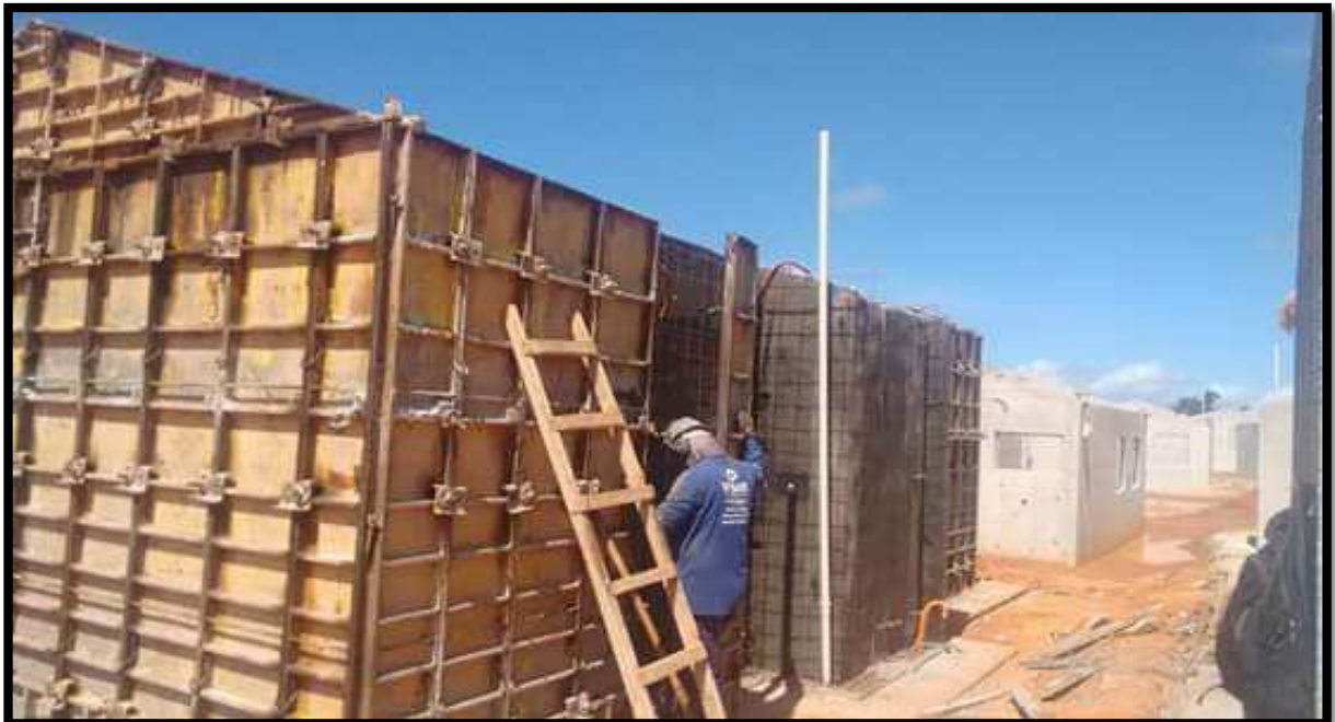
Fig. 4 – Finalização da montagem dos painéis
