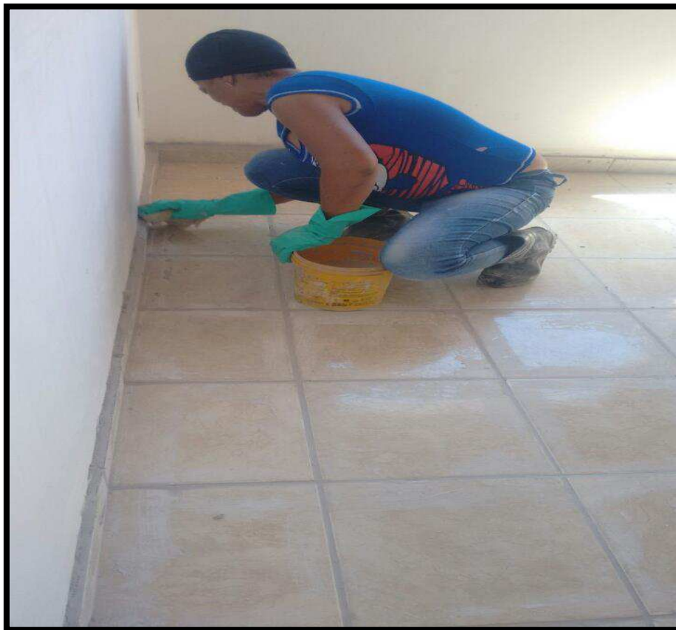
Fig. 13 – Rejunte cerâmico
