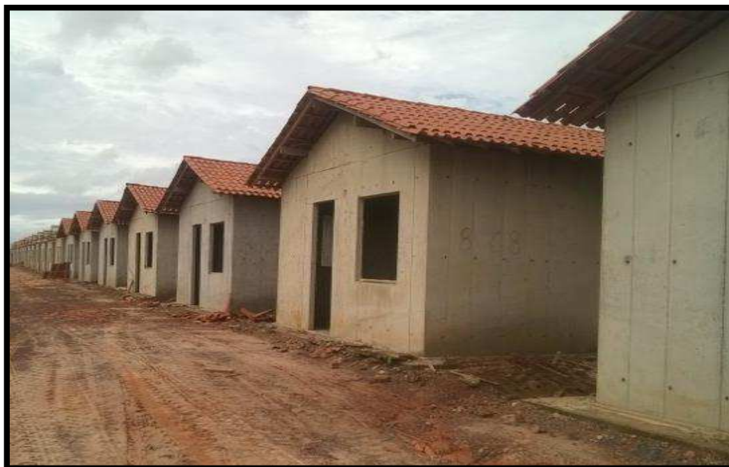
Fig. 9 – Finalização da cobertura
