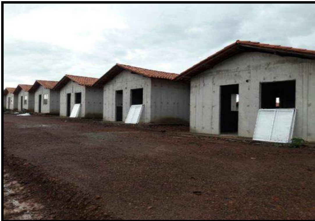
Fig. 10 – Colocação das esquadrias
