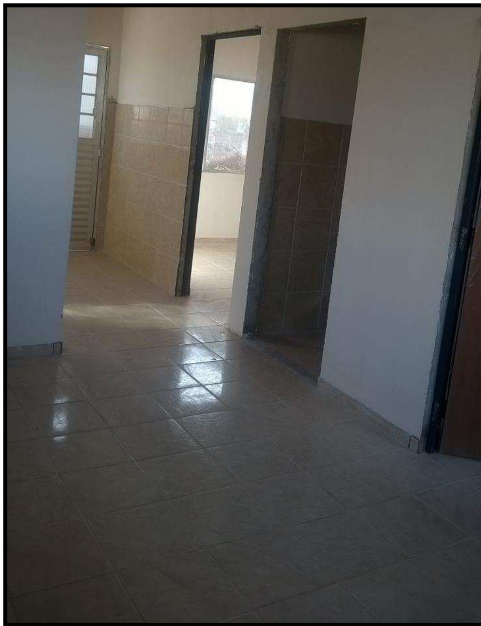
Fig. 16 – Piso e revestimento de cerâmica
