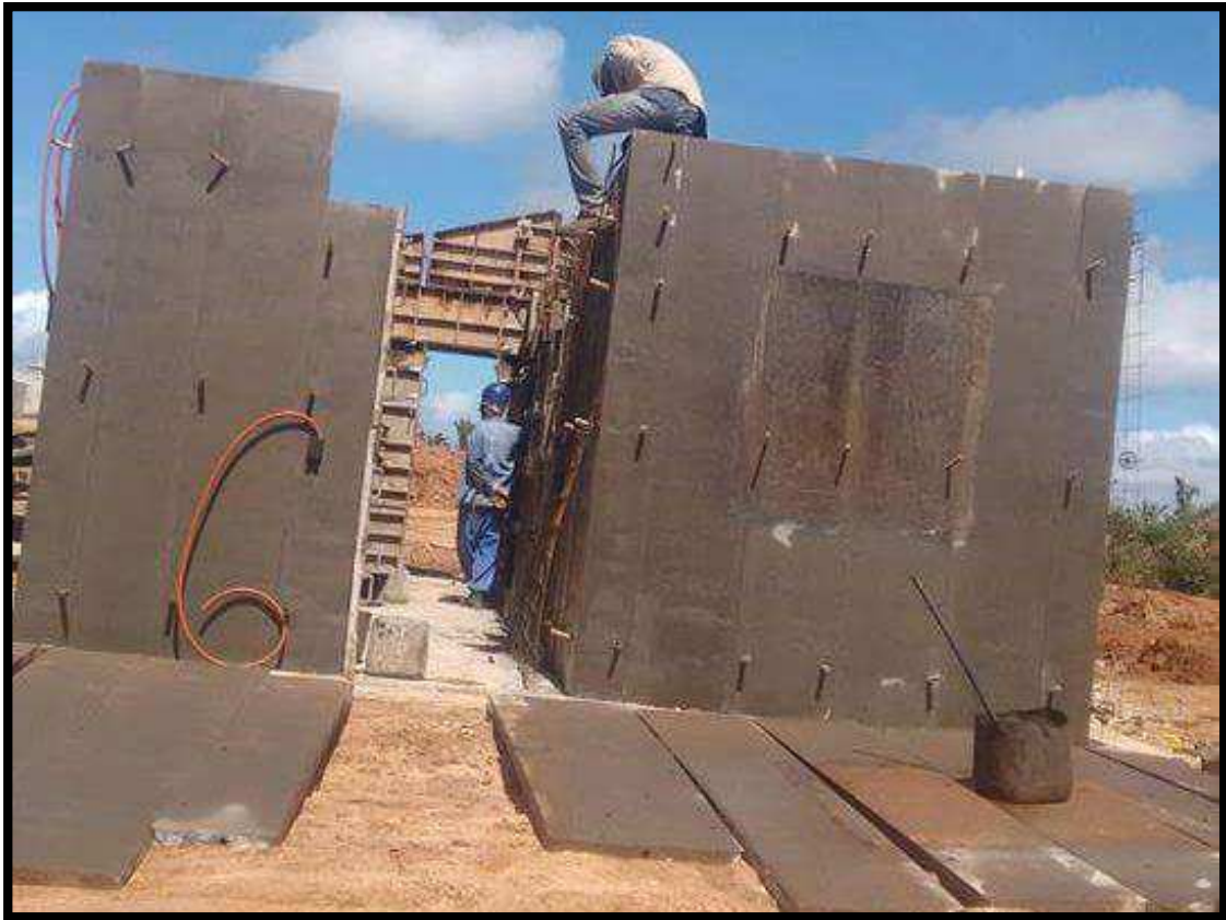
Fig. 3 – Montagem dos painéis
