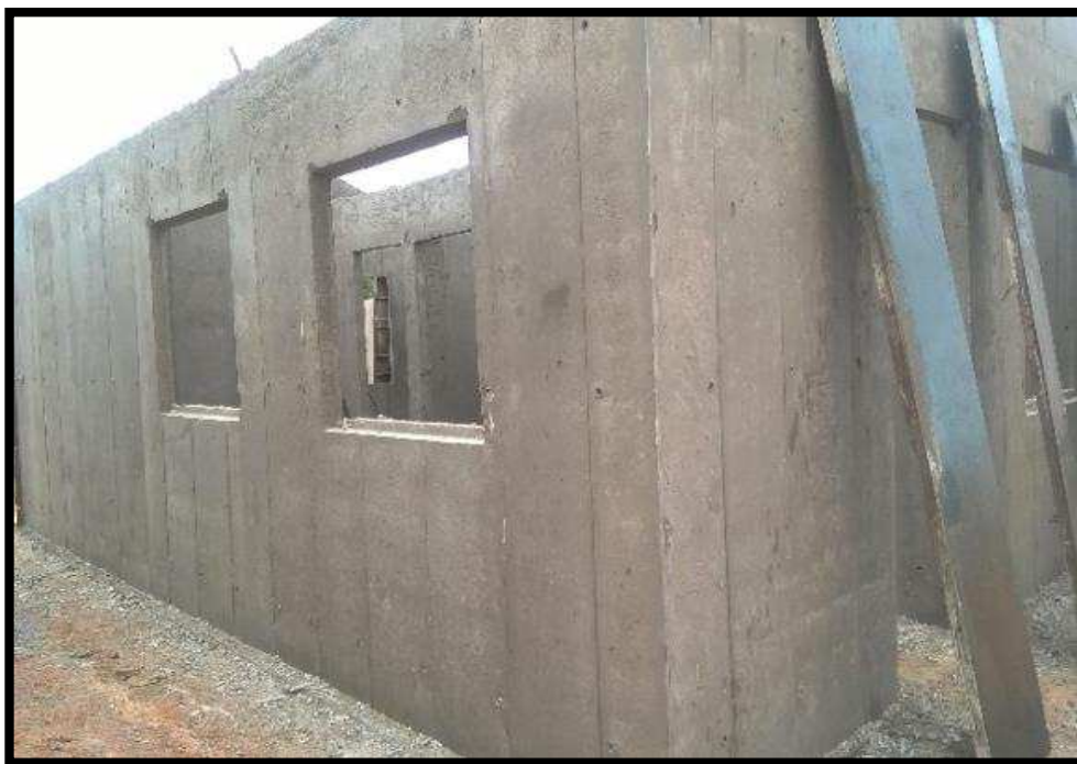
Figura 18 – Parede de Concreto Autoadensável (Residencial Mato Grosso)
