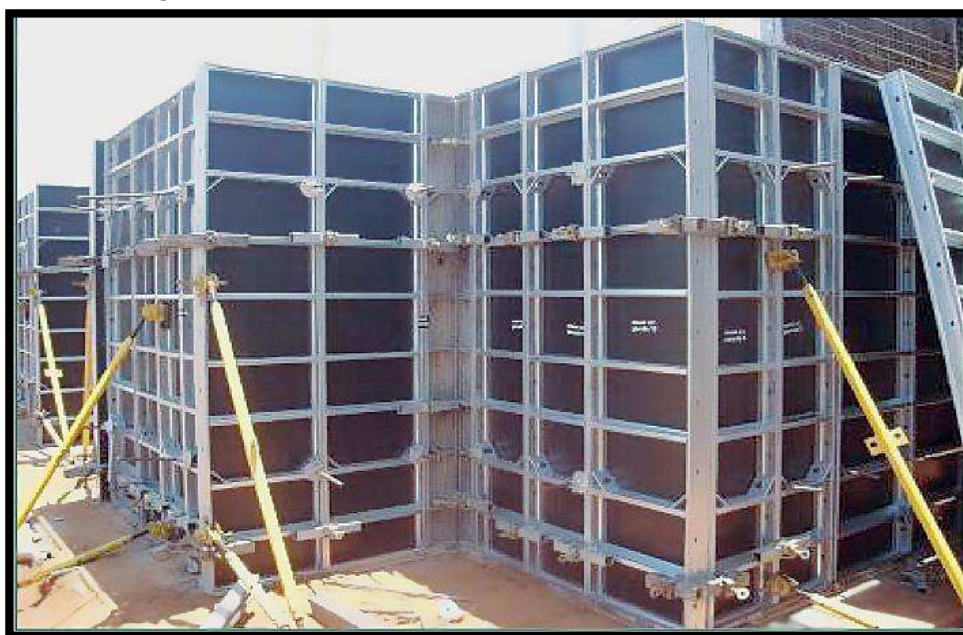
Figura 16 – Fôrmas Metálicas com Contado de Madeira
