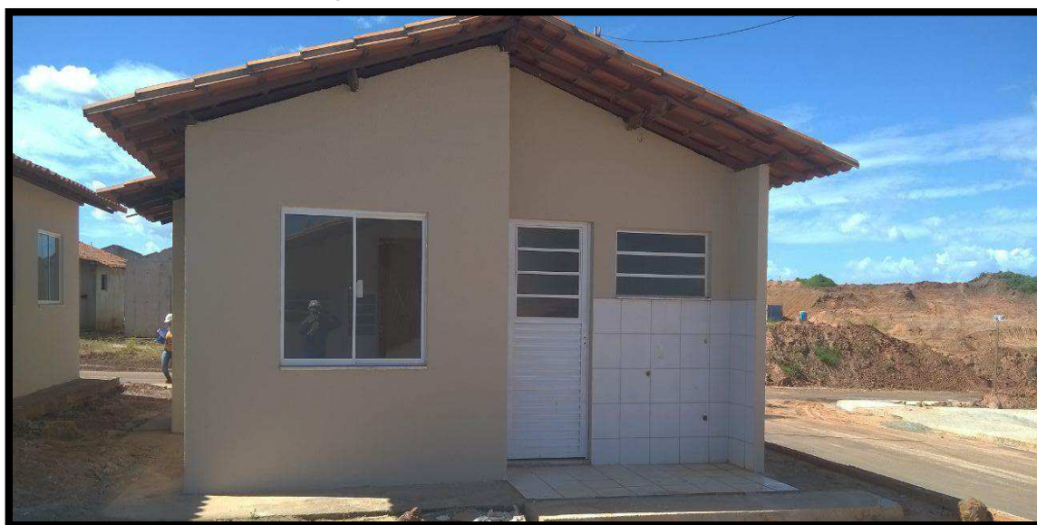
Fig. 24 – Unidade habitacional com seladora
