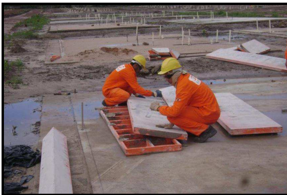
Figura 27 – Limpeza dos painéis.
