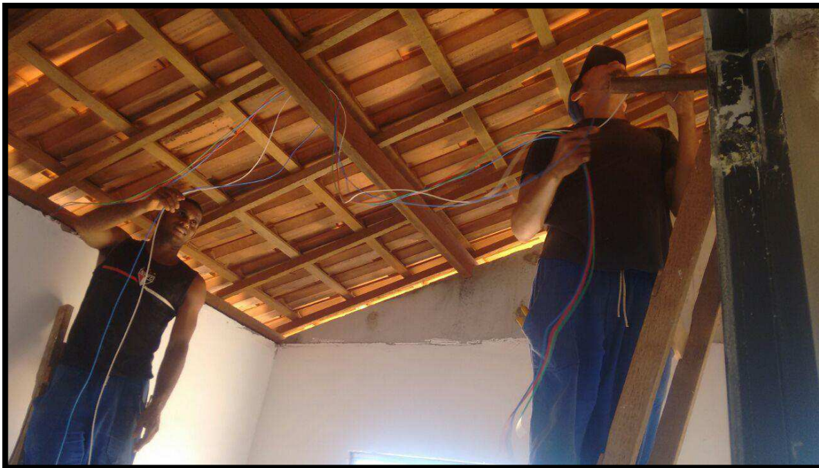
Fig. 17 – Execução da instalação elétrica
