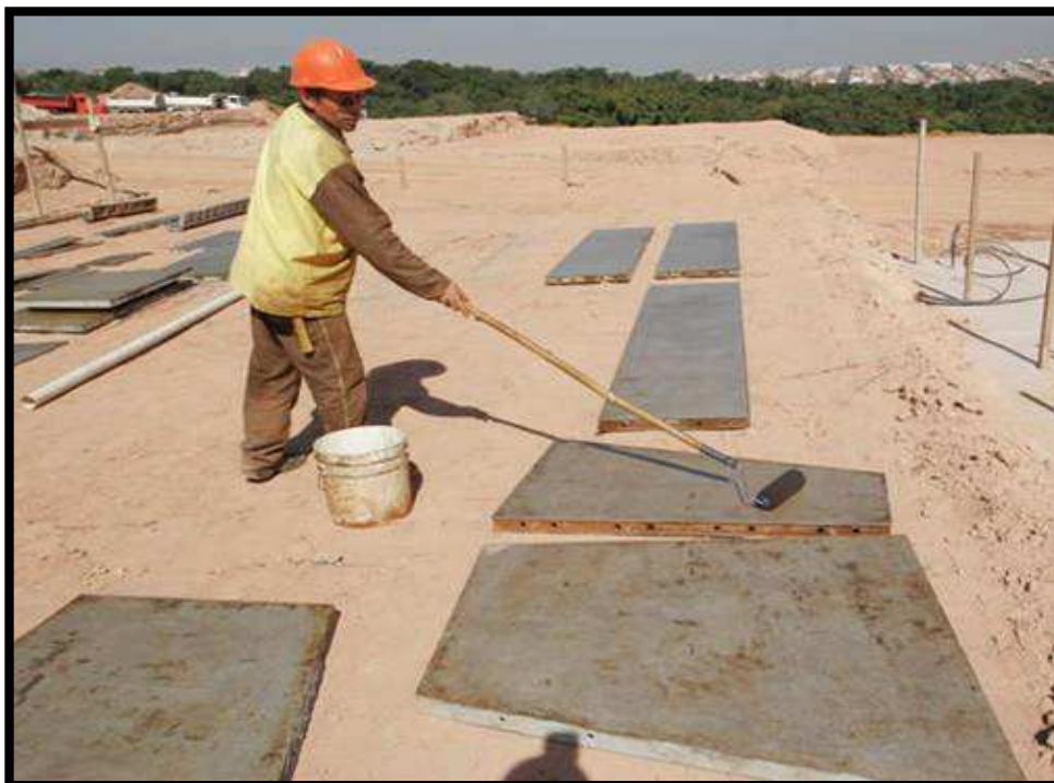
Figura 23 – Aplicação de desmoldante nos painéis
