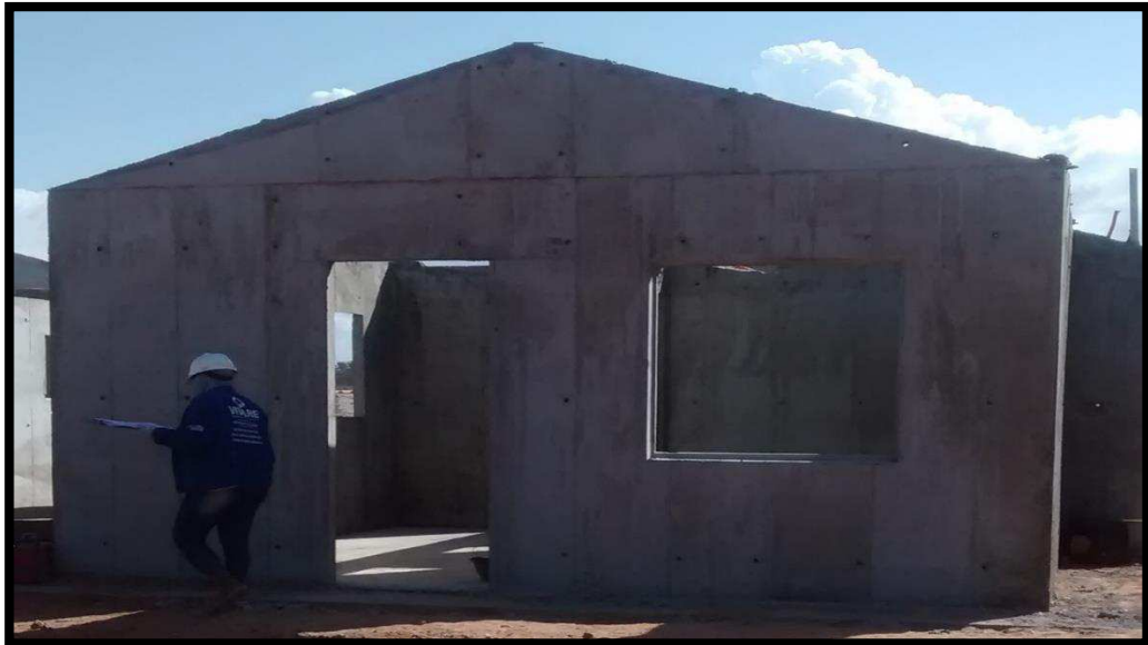
Fig. 6 – Parede concretada
