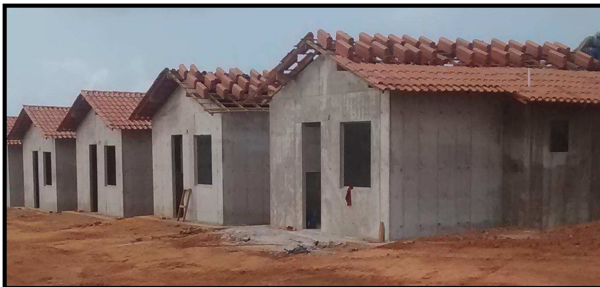
Figura 6 – Execução da Cobertura
