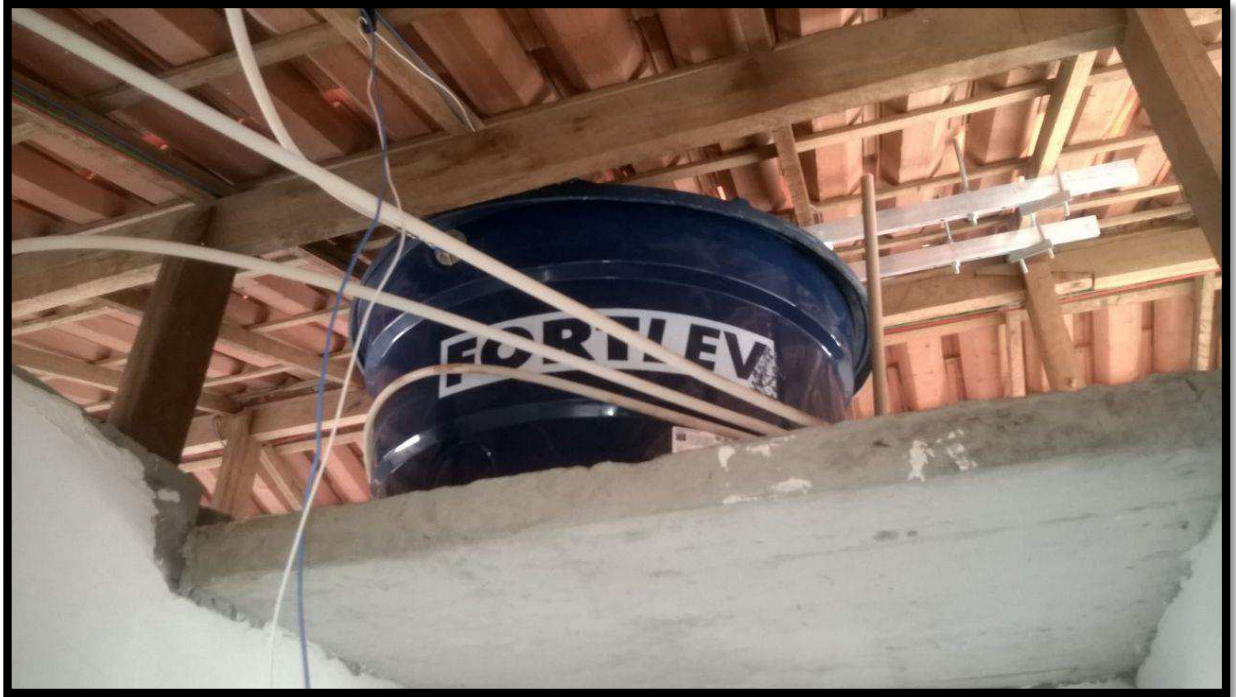
Fig. 21 – Instalação do tubo pex na caixa d'água
