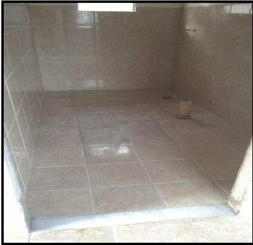
Fig. 14 – Revestimento cerâmico do banheiro
