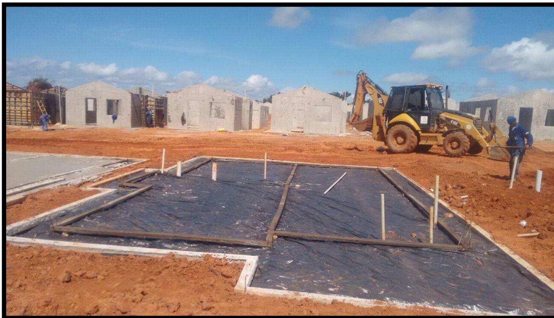
Fig. 1 – Montagem da fôrma do radier
