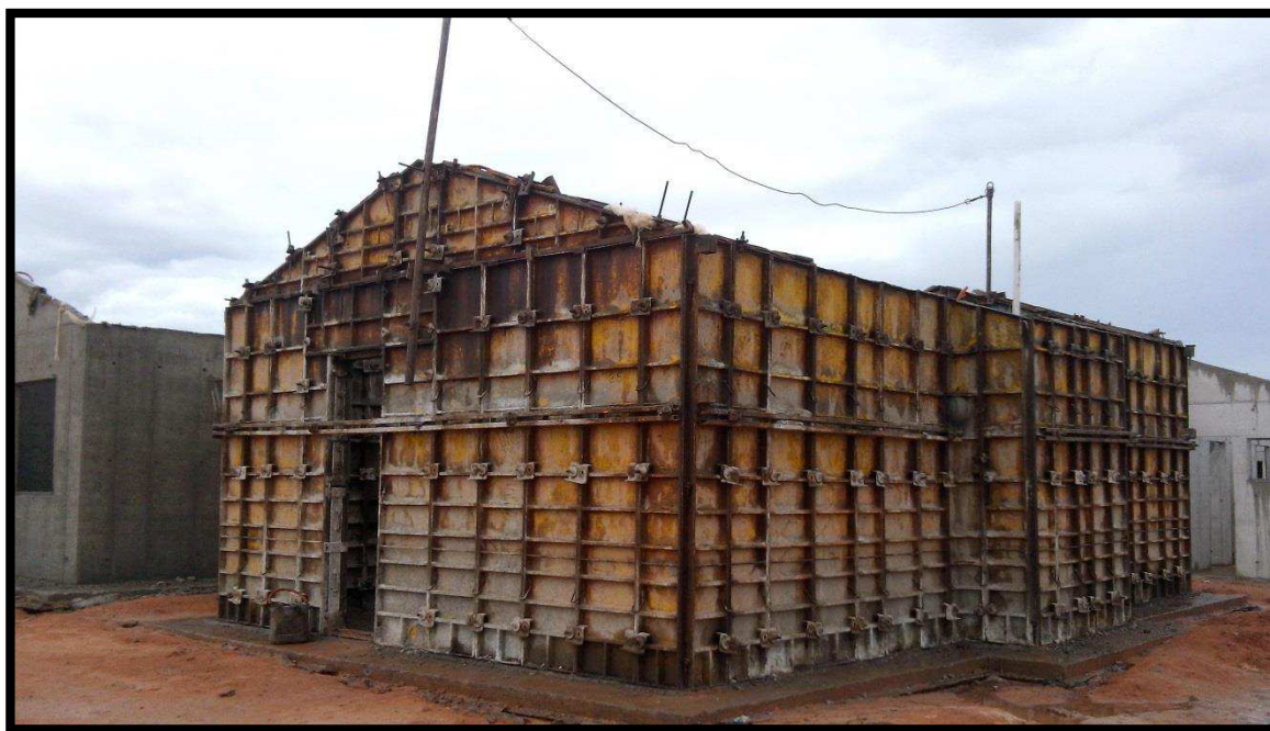
Figura 13 – Forma Metálica usada para execução de paredes de concreto.
