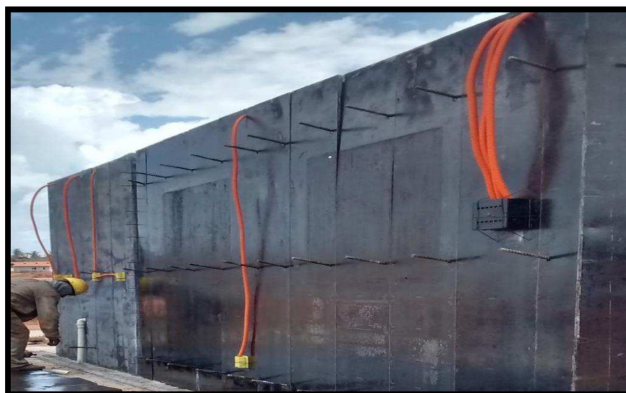
Figura 21 – Colocação dos eletrodutos em paredes de concreto
