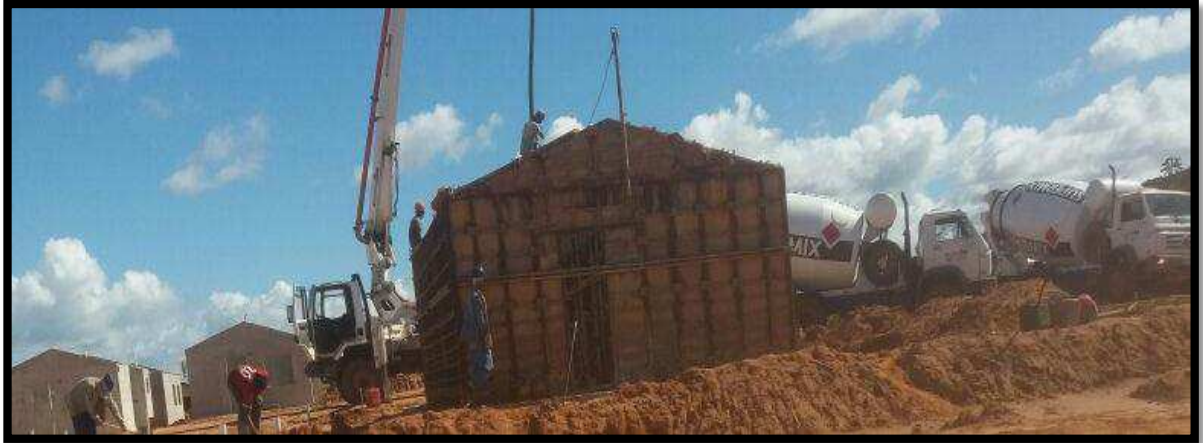
Fig. 5 – Concretagem da parede
