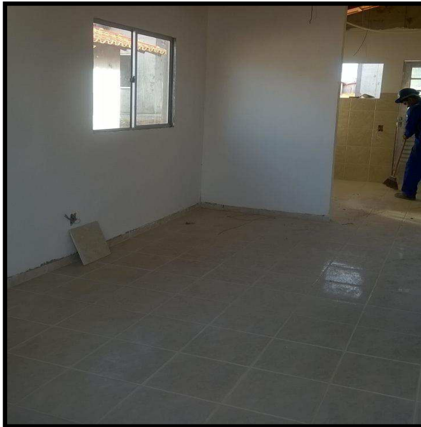
Fig. 15 – Revestimento de gesso e cerâmico da UH
