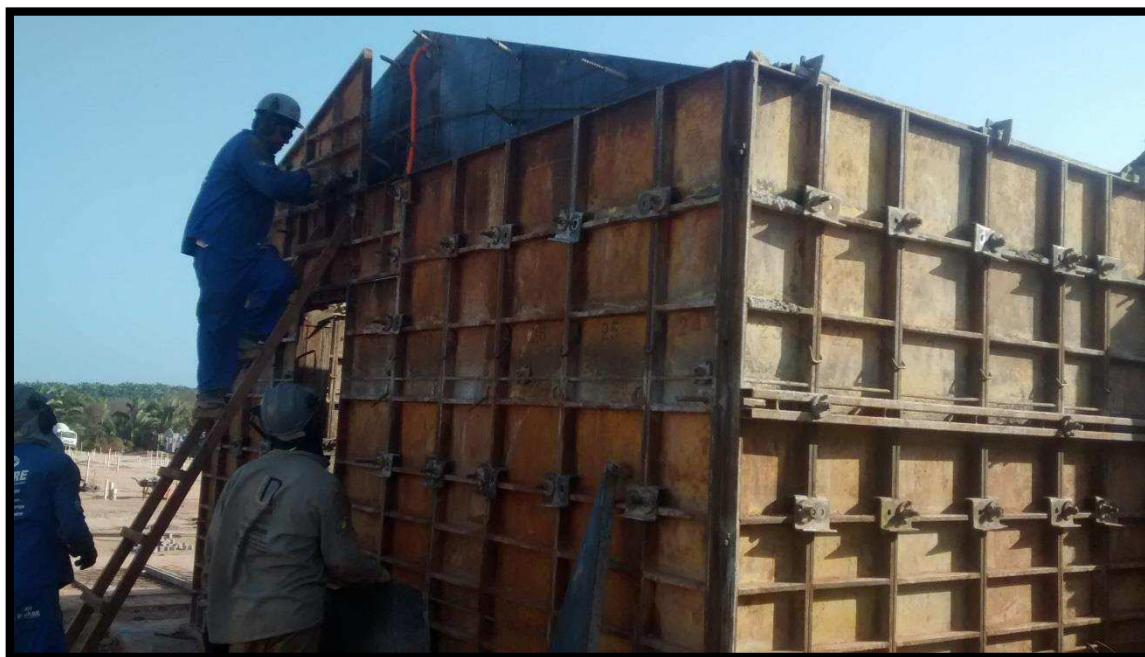
Figura 24 – Fase Final da Montagem da Fôrma
