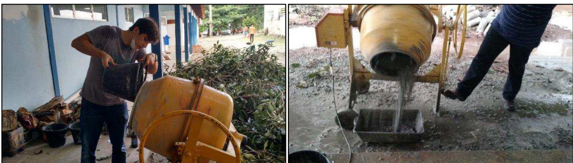
Figura 15 - Fabricação do Concreto.
