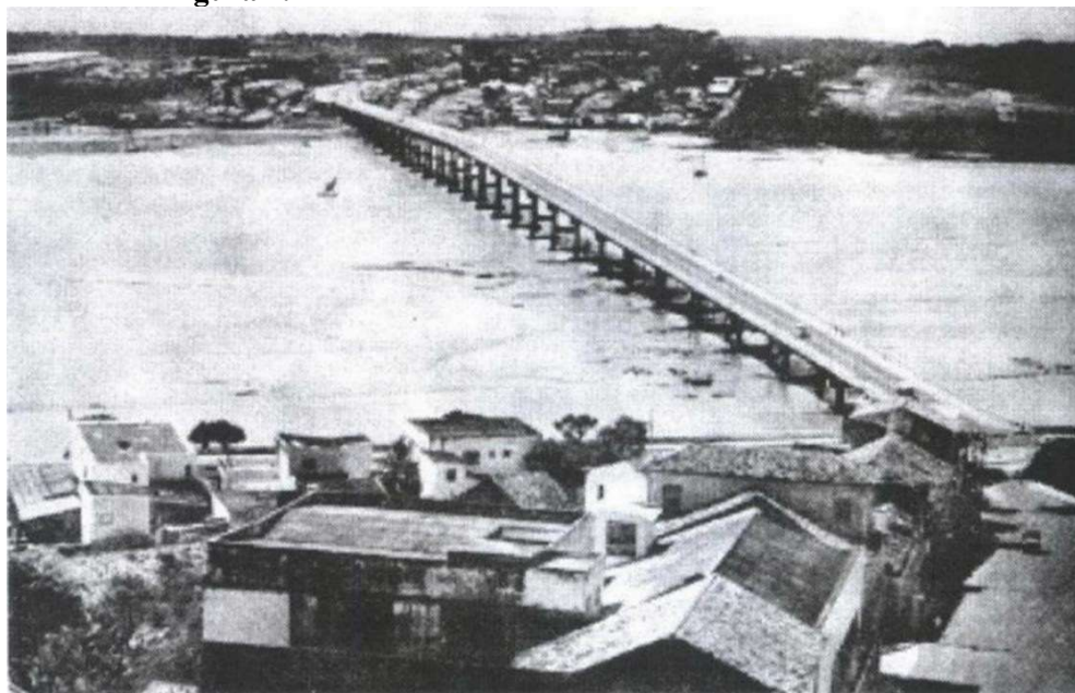
Figura 4: Ponte do São Francisco vista do Centro Histórico
