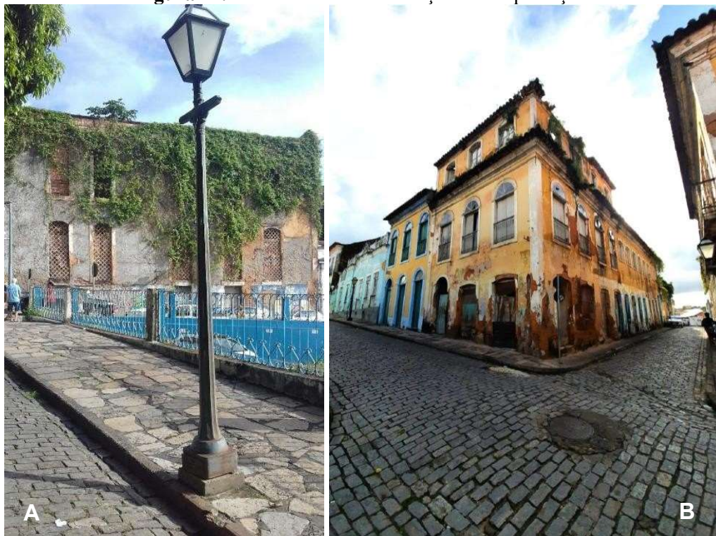
Figura 21: Prédios em estado avançado de depredação
