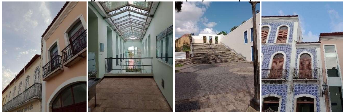
Figura 26: Exemplos de recuperações e adequações
