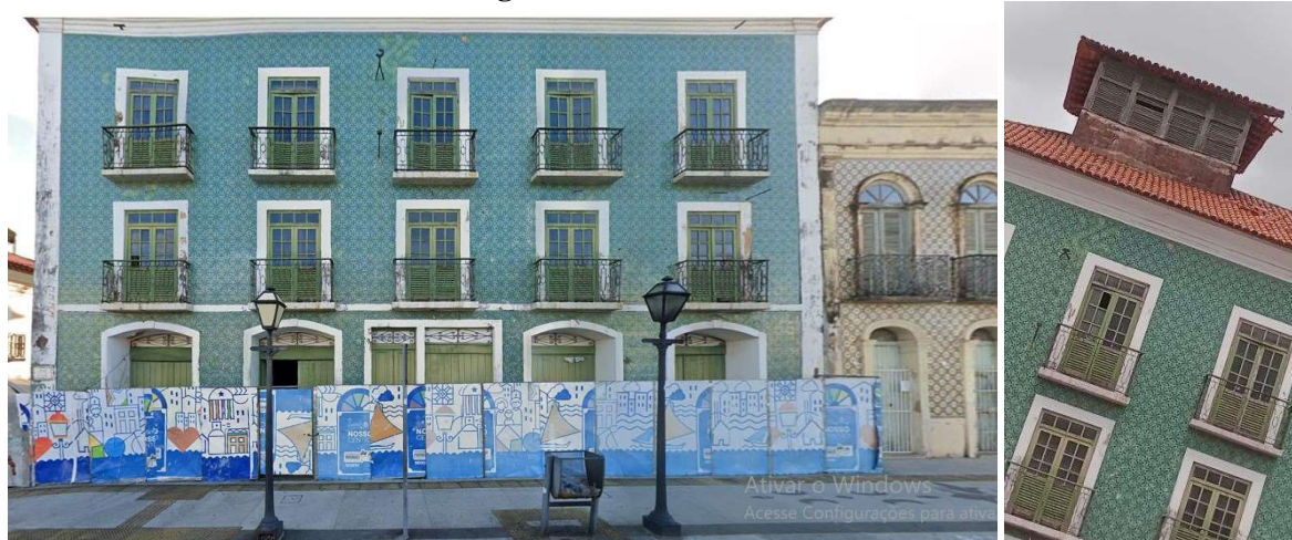
Figura 16: Solar dos Belfort
