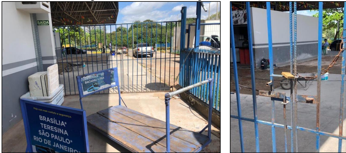
Figura 18 – Saída de Emergência trancada
