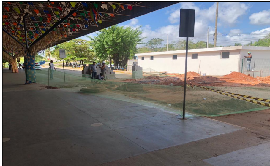
Figura 13 – Obra na via de acesso ao Terminal
