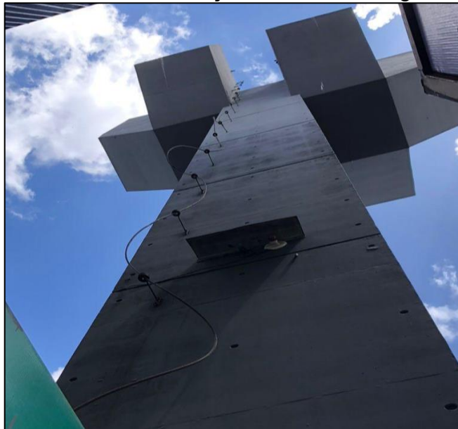
Figura 15 – Sistema de Proteção Contra Descarga Atmosférica
