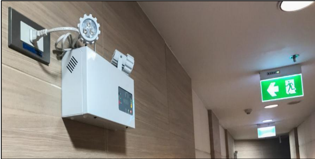
Figura 5 – Exemplo de Iluminação de Emergência
