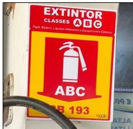
Figura 22 – Placa sem efeito fotoluminescente
