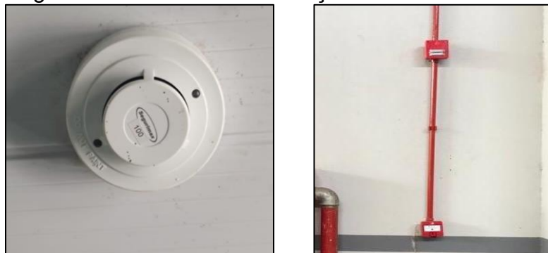
Figura 21 – Detector de Fumaça e Acionador Manual
