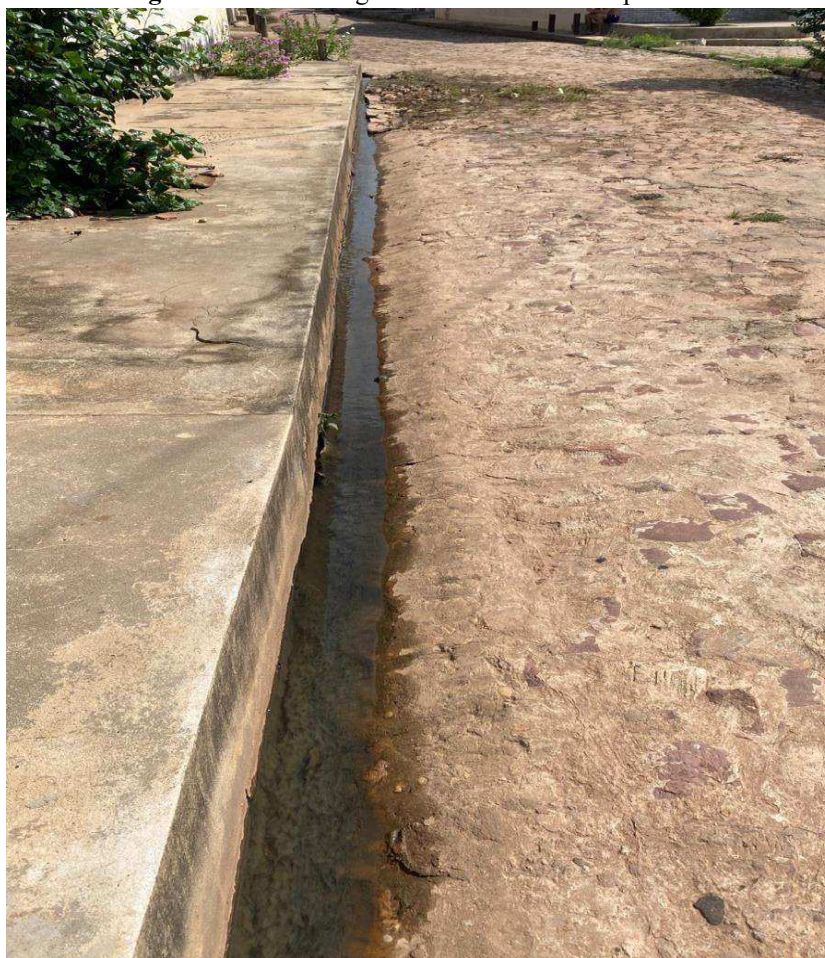
Figura 3 – Vala de esgoto a céu aberto em via pública
