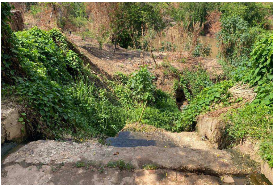
Figura 2 – Córrego com presença de esgoto doméstico e vegetação degradada.
