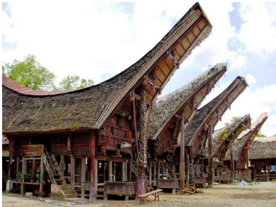
Figura 15 - Construções sobre estacas denominados de Tongkonan nas ilhas da Indonésia.
