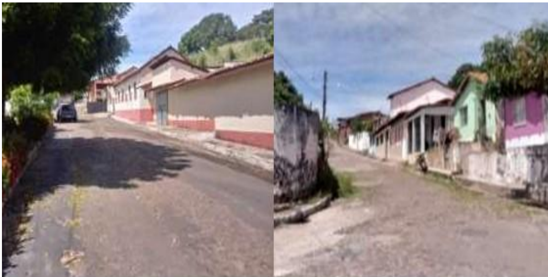
Figura 34: imagens atuais da rua Dr. Moacir Coimbra
