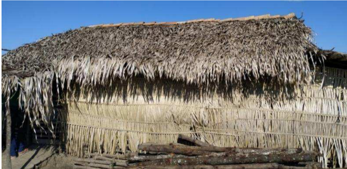
Figura 8 - Instalação (retilo) com cobertura em palha de babaçu, utilizada como abrigo e centro de manejo para criação de suínos baixadeiros localmente adaptados no município de São Bento, Maranhão.
