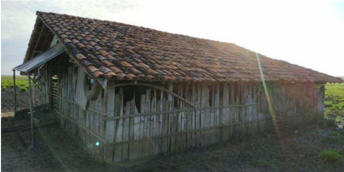
Figura 7 – Instalação (retilo) com cobertura de telha de barro, utilizada como abrigo e centro de manejo para criação de suínos baixadeiros localmente adaptados no município de São Bento, Maranhão.
