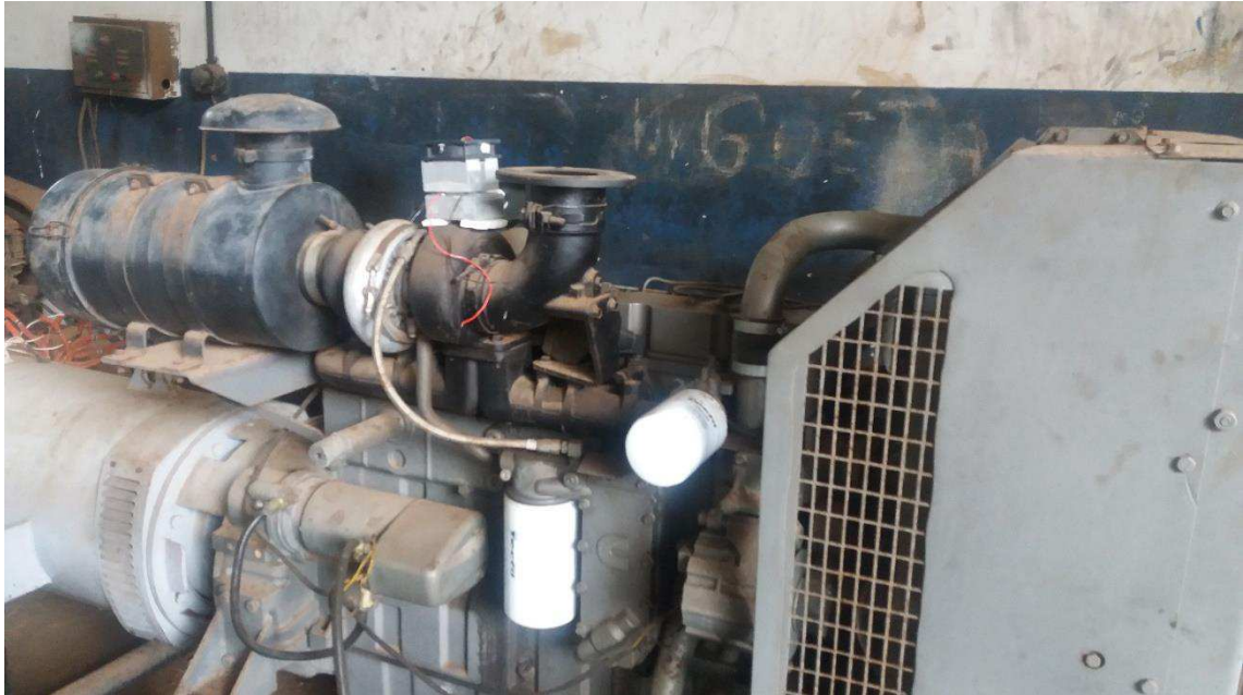
Figura 10 - Gerador Termoelétrico Acoplado no Sistema de Exaustão do Motor
