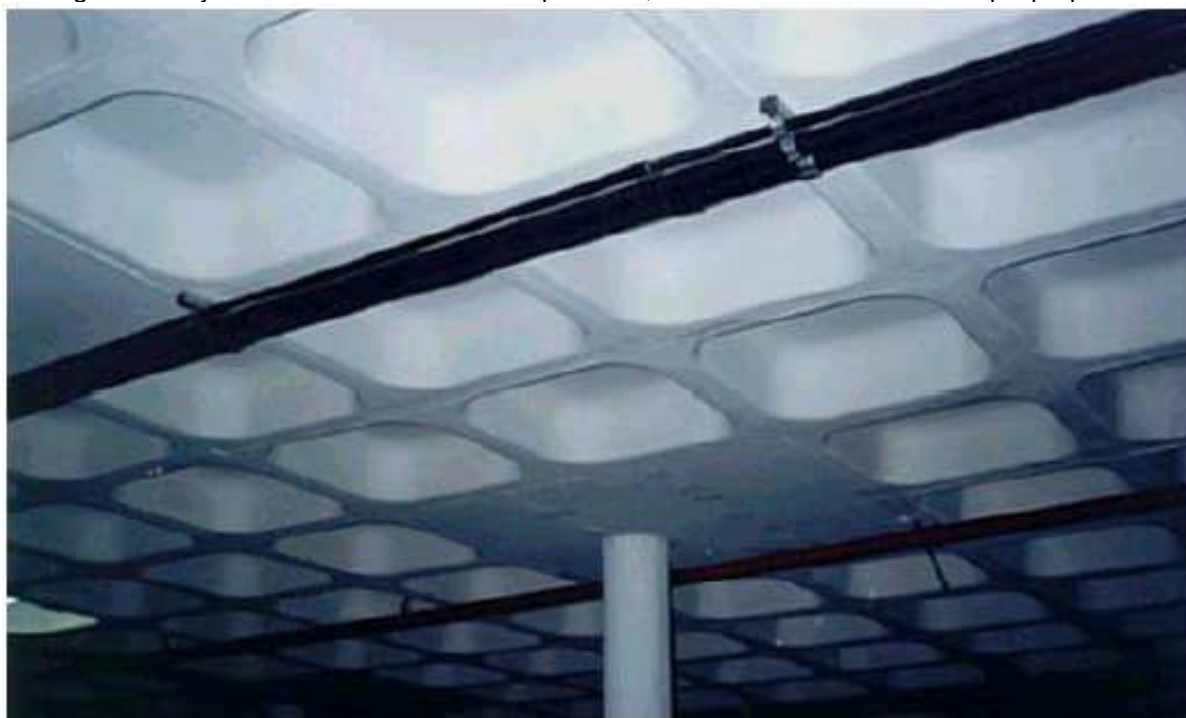
Figura 5 - Laje nervurada com nervuras aparentes, construídas com fôrmas de polipropileno.
