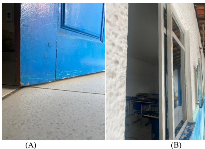
Figura 9: Fresta na porta e detalhe da janela da sala D-01.
