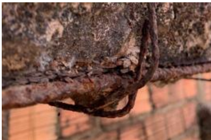
Figura 5 - Corrosão nas armaduras
