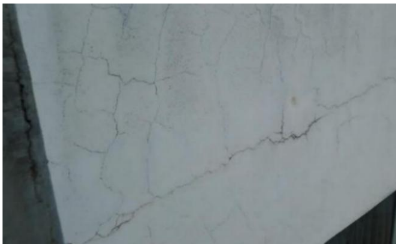
Figura 1- Fissura no revestimento externo da fachada
