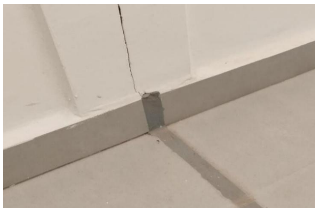
Figura 7- Preenchimento da Junta com Mastique PU 40
