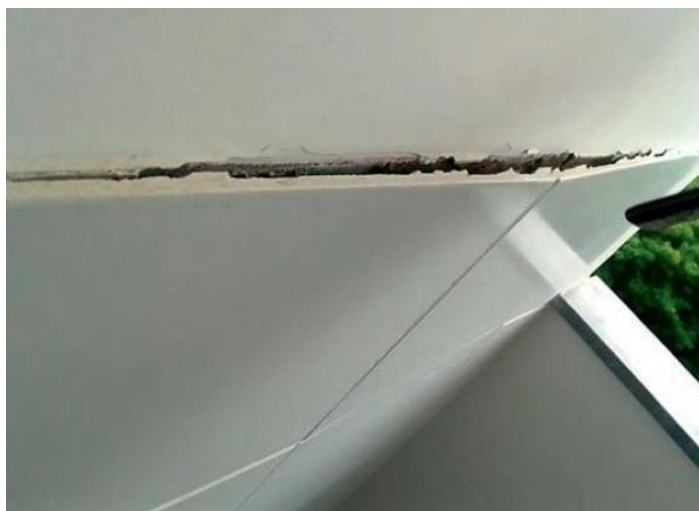
Figura 4 - Deslocamento cerâmico em revestimento interno
