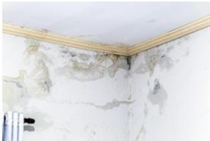
Figura 3 - Parede com infiltração
