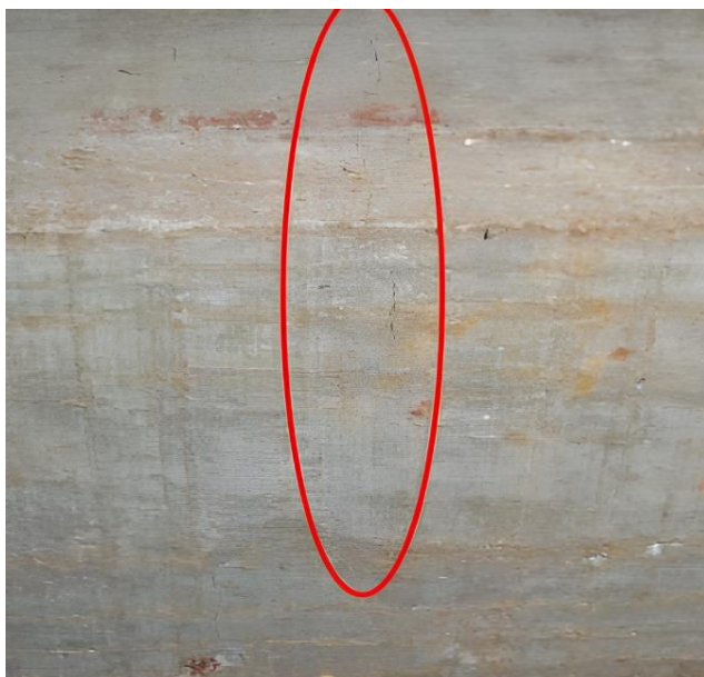
Figura 2 - Trinca em viga de sustentação
