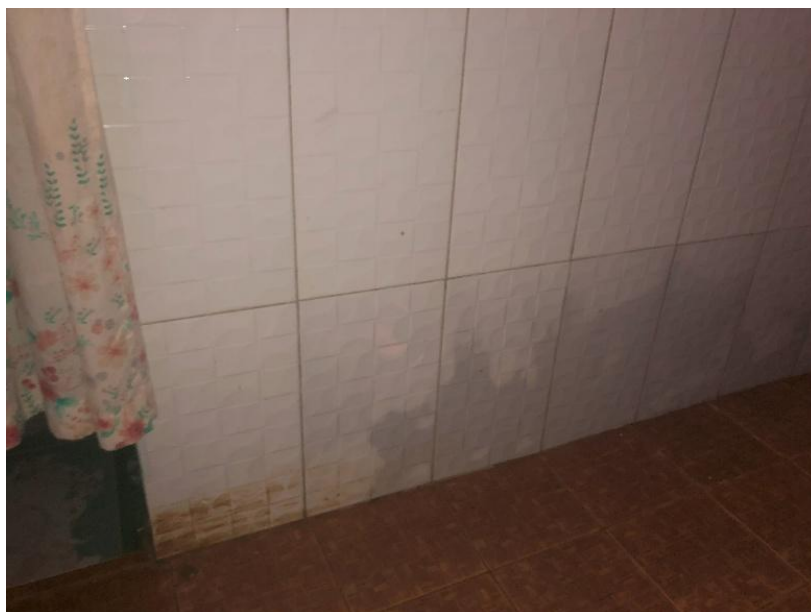
Figura 21: Manchas de umidade no revestimento cerâmico do imóvel 06.
