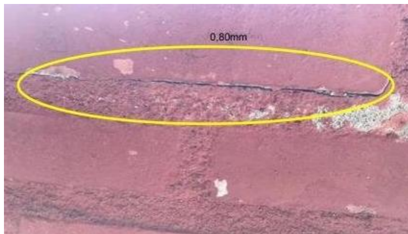
Figura 9: Fissuras de movimentações higroscópica.
