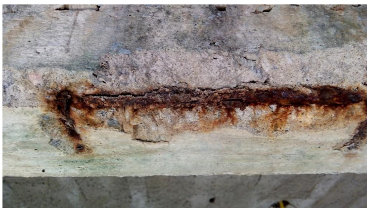
Figura 13: Corrosão em armadura.
