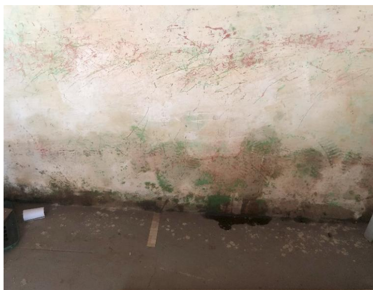
Figura 19: Manchas de umidade do imóvel 02.
