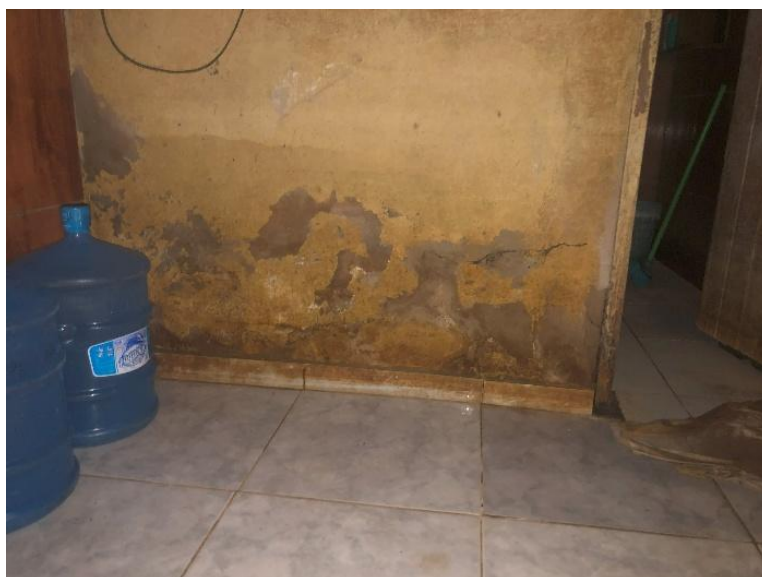
Figura 27: Degradação da argamassa da parede do imóvel 07.
