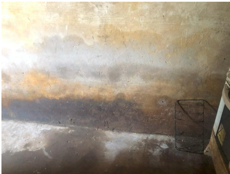
Figura 33: Manchas de umidade, mofo e bolor em parede no imóvel 22.
