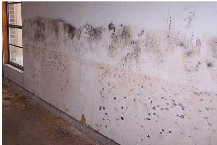
Figura 10: Manchas de umidade na parede.
