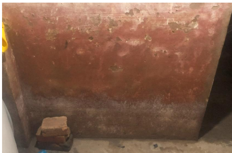
Figura 34: Degradação da argamassa em parede do imóvel 22.
