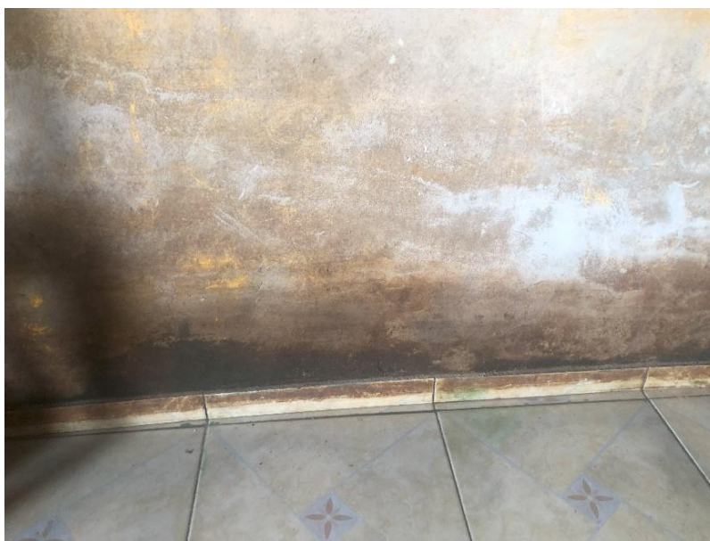
Figura 32: Manchas de umidade no imóvel 22.
