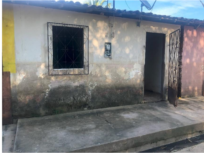
Figura 24: Fachada do imóvel 06 com a presença de Mofo e bolor.
