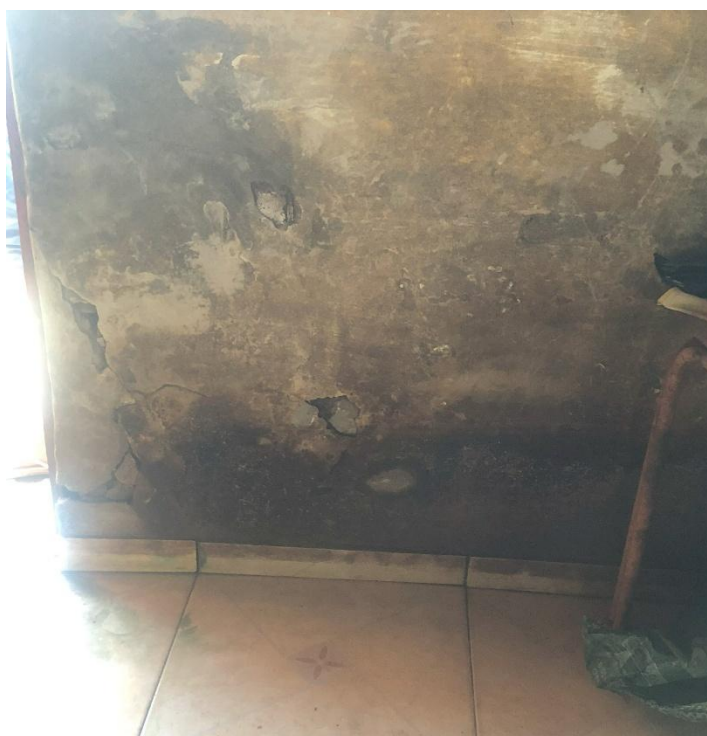
Figura 35: Degradação da argamassa em uma outra parede do imóvel 22.
