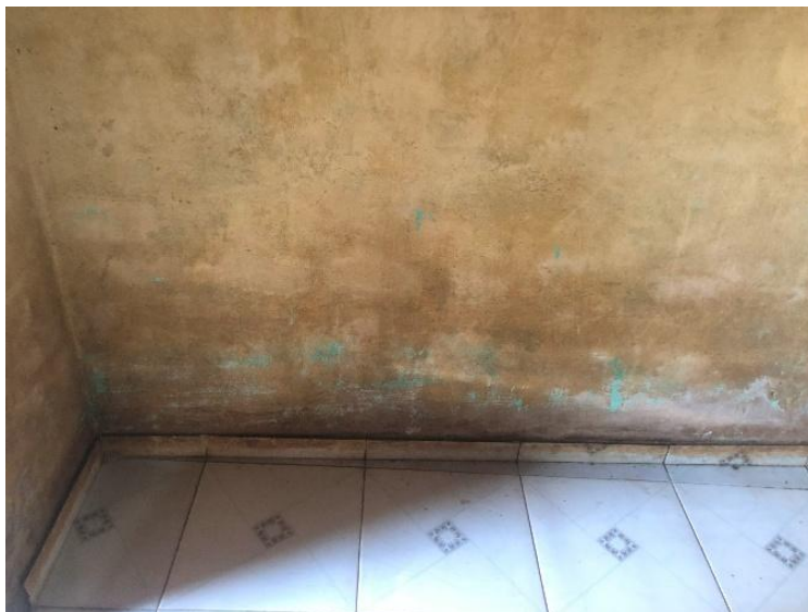
Figura 26: Manchas de umidade no imóvel 07.
