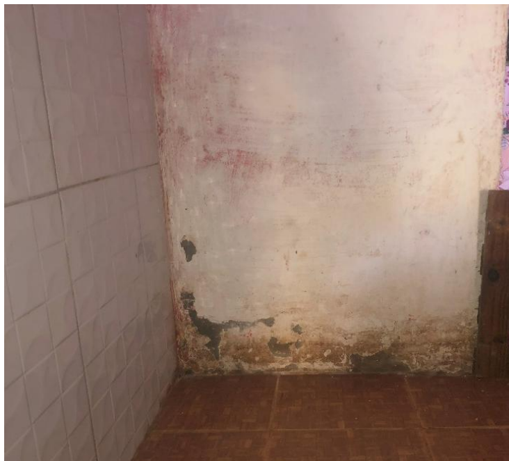
Figura 22: Degradação da argamassa na parede do imóvel 06.
